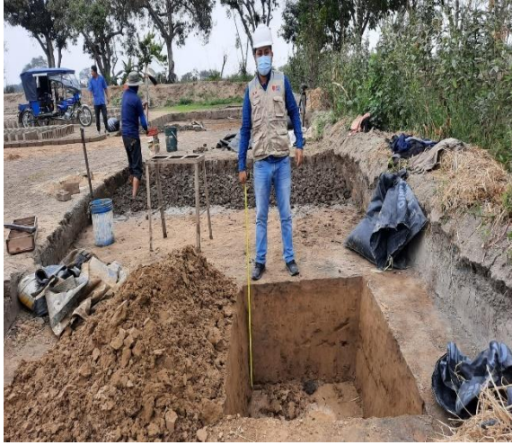
Figuras N°01. Calicata para la obtención de la materia prima.
