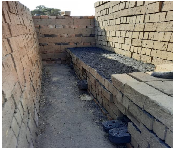
Figuras N°10. Colocado de ladrillo en Horno.
