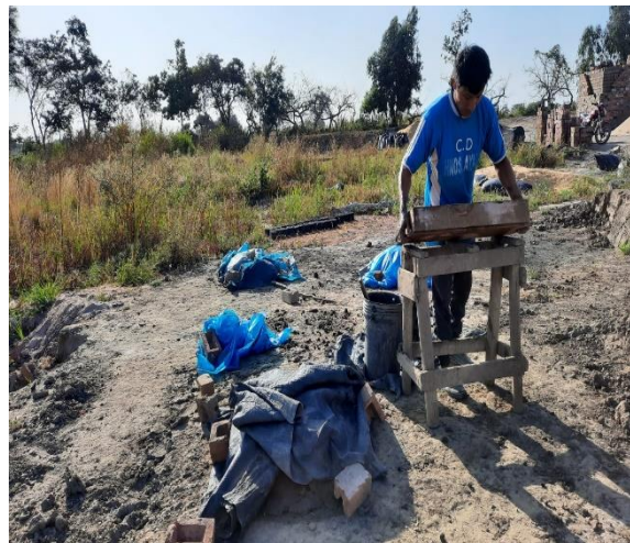
Figuras N°07. Proceso de mezcla para moldeo. Figuras N°08. Moldeo de ladrillos.
