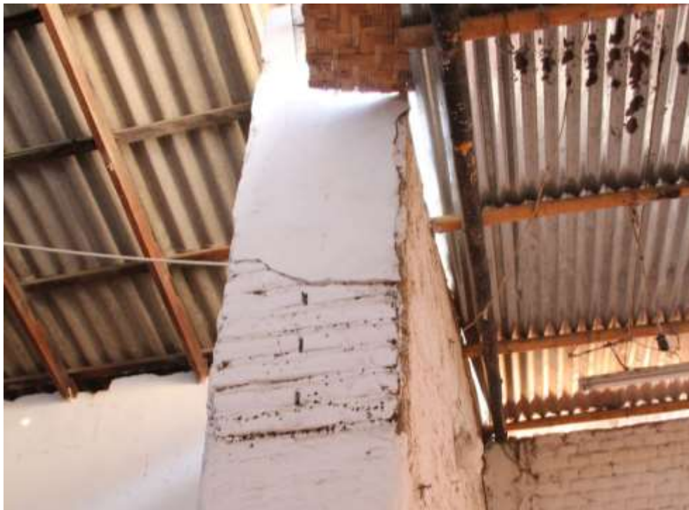
Figura 33 Vivienda antigua del distrito de Catacaos
