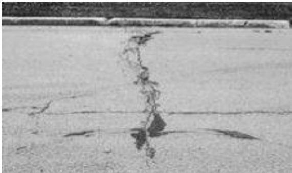
Fisuras Longitudinales y Transversales
