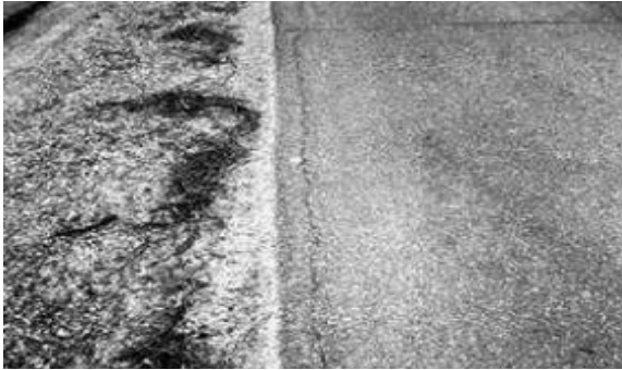
Fisuras Longitudinales y Transversales
