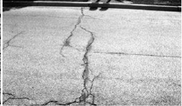
Fisura de reflexión de junta
