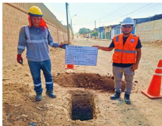
Foto 5: Extracción de muestra de la calicata 3
