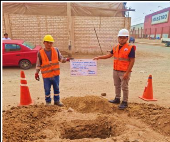
Foto1: Extracción de muestra de la calicata 1
