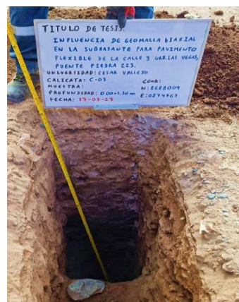
Foto 6: Medición de 1.50 m de profundidad de la calicata 3
