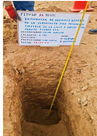
Foto 2: Medición de 1.50 m de profundidad de la calicata 1
