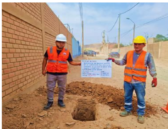
Foto 3: Extracción de muestra de la calicata 2
