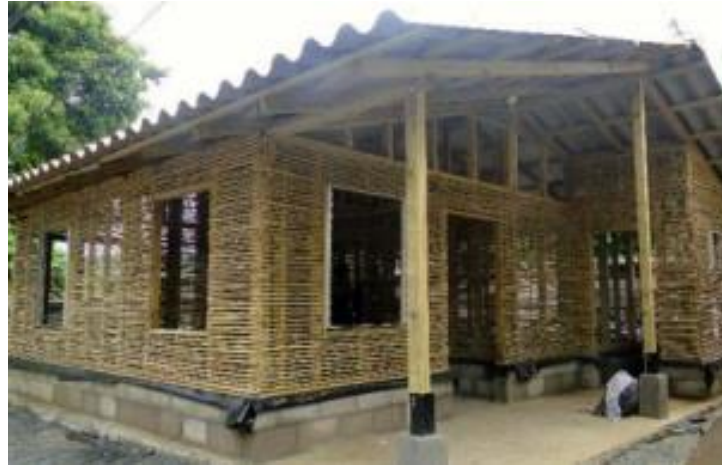
Figura N° 4: Casas de bahareque encementado. Fuente: Reporte post-sismo sobre estructuras de bambú, y recomendaciones para la reconstrucción con bambú en la costa ecuatoriana (INBAR, 2015)
