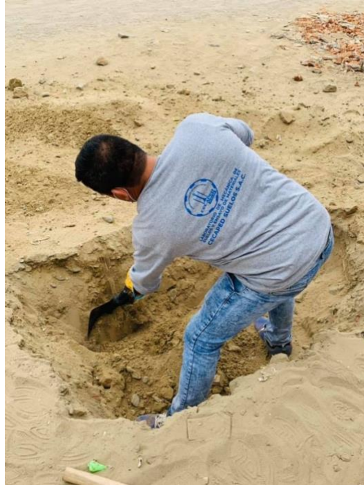
Figura 21. Ejecución del Procedimiento: realizar excavación
