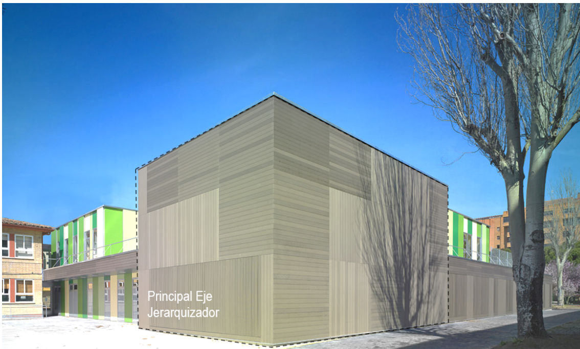
Figura 53. Vista en la esquina Fray Pedro Ponce de León.
