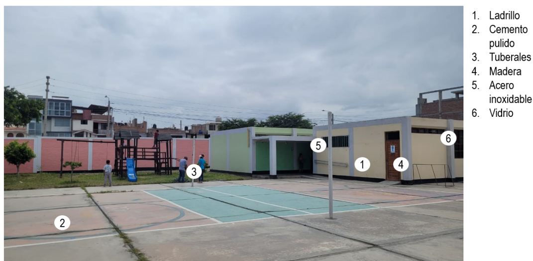
Figura 28. Materiales empleados en su construcción.
