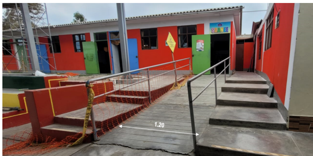
Figura 16. Acceso a las aulas Centro de educación especial N.º 01
