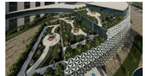
Figura3: Vista exterior del proyecto, muros y techos verdes. UNIVERSIDAD PRIVADA DE TACNA(2020) https://repositorio.upt.edu.pe/bitstream/handle/20.500.12969/2229/Camesplanblames-Cazorla-Verde-Sanchez.pdf?sequence=1&isAllowed=y
