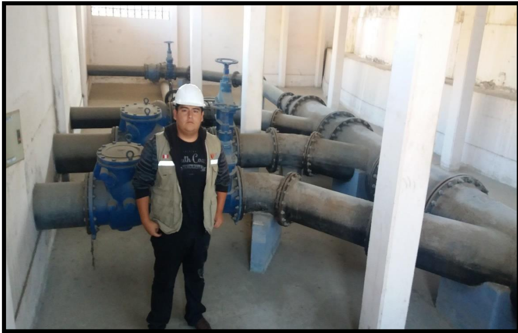
FOTOGRAFÍA N° 06: También se inspecciono la caseta de válvulas de los reservorios.
