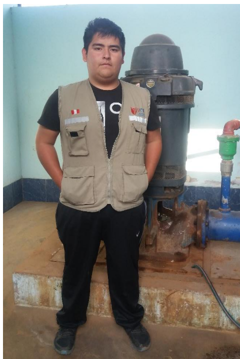
FOTOGRAFÍA Nº 04: También se hizo la inspección por la parte donde se encuentra el motor de la bomba.
