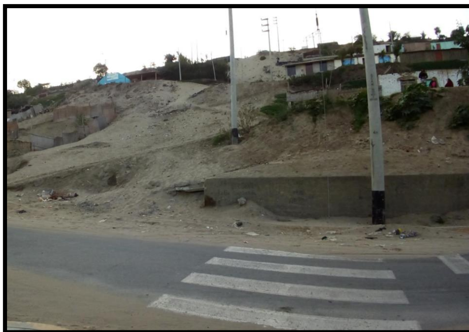
Figura 1: Inicio del muro de contención que será evaluado en la av. Arequipa del pueblo joven la Primavera, distrito de Chimbote.
