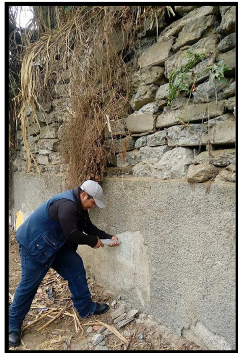
Figura 8: Ensayo del esclerómetro en los dos tramos del muro para determinar la consistencia del concreto.
