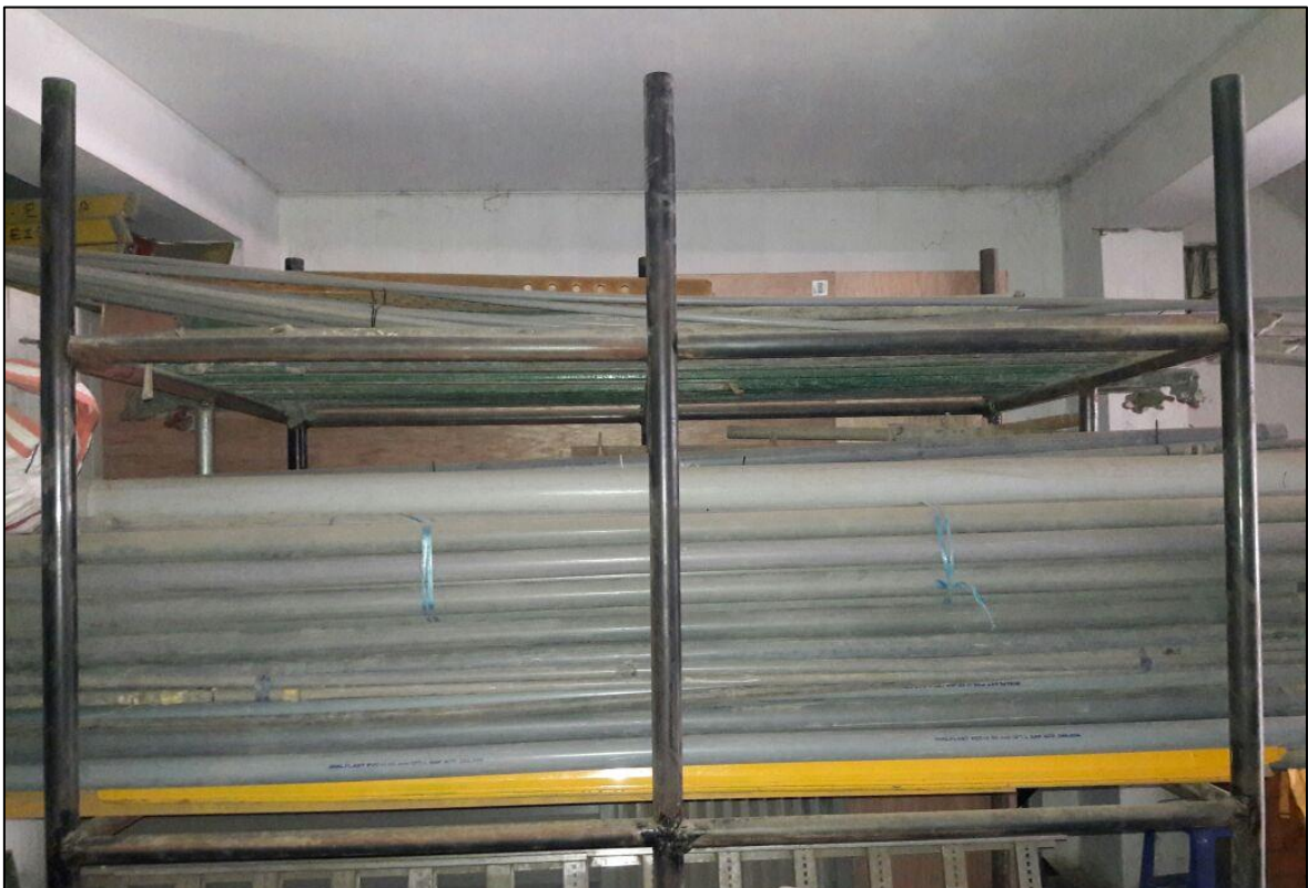
Figura 14. Tuberías conduit y PVC ordenados Fuente: Elaboración propia
