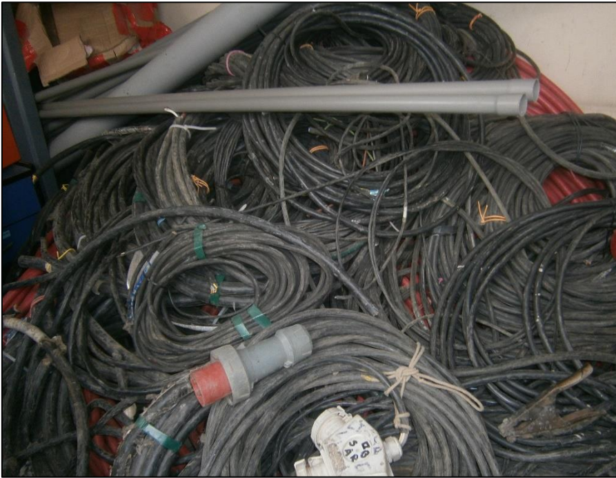
Figura 11. Cables eléctricos desordenados Fuente: Elaboración propia
