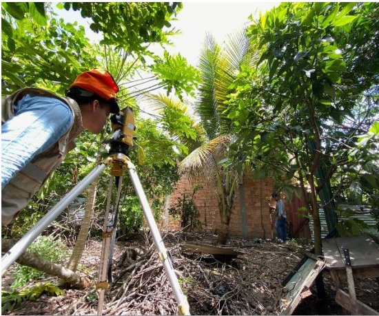
Se muestra levantamiento topográfico del vértice 4.
