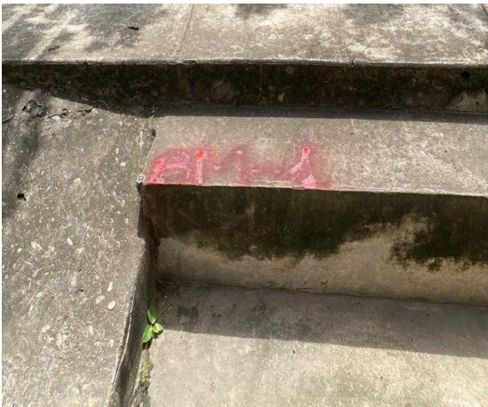
Se muestra señal indicadora del Bench Marck (BM-01).
