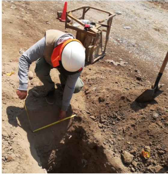
Foto 9. Toma de medida del ancho a 0.50 m para la calicata C2
