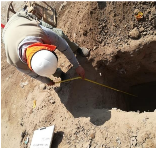
Foto 7. Toma de medida de la profundidad a 1.50 m para la calicata C2
