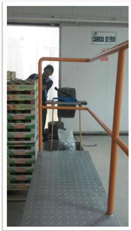
Foto 8.5.4 Vista del ingreso.
