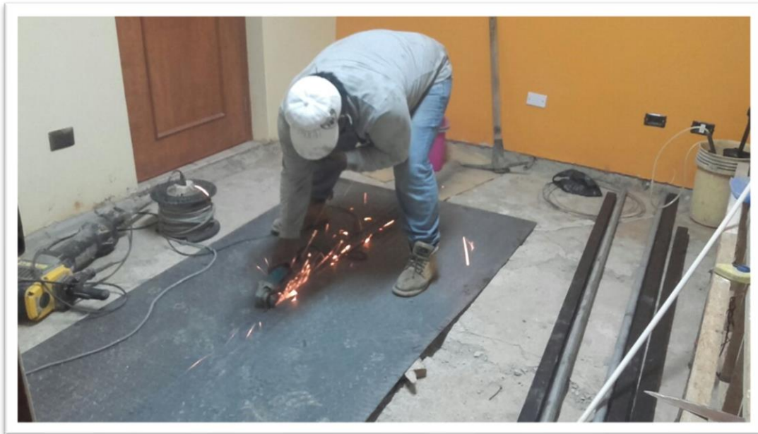
Foto 8.3.3 Corte de la plancha.
