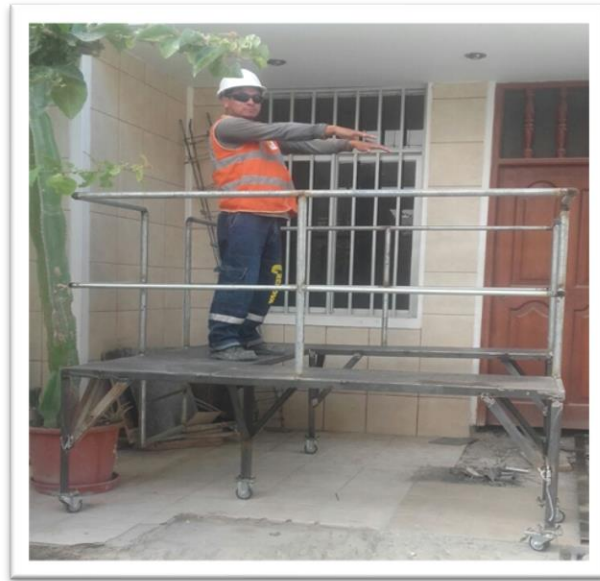
Foto 8.3.9 Operario utilizando la estructura.
