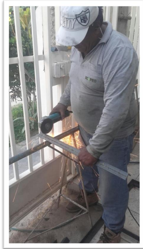
Foto 8.3.1 Corte de la estructura.
