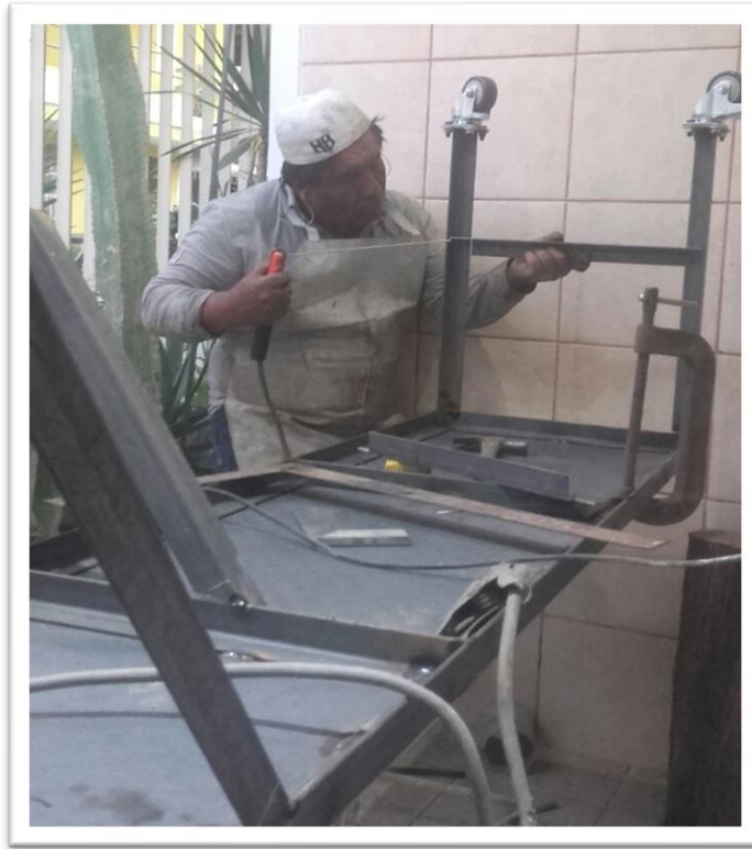
Foto 8.3.5 Soportes soldados a la estructura.
