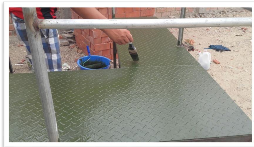
Foto 8.3.10 Aplicación de base Zincromato
