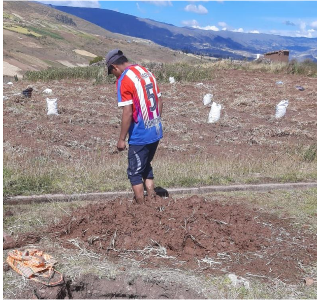
Figura 38: Preparación de la mezcla (fuente propia).
