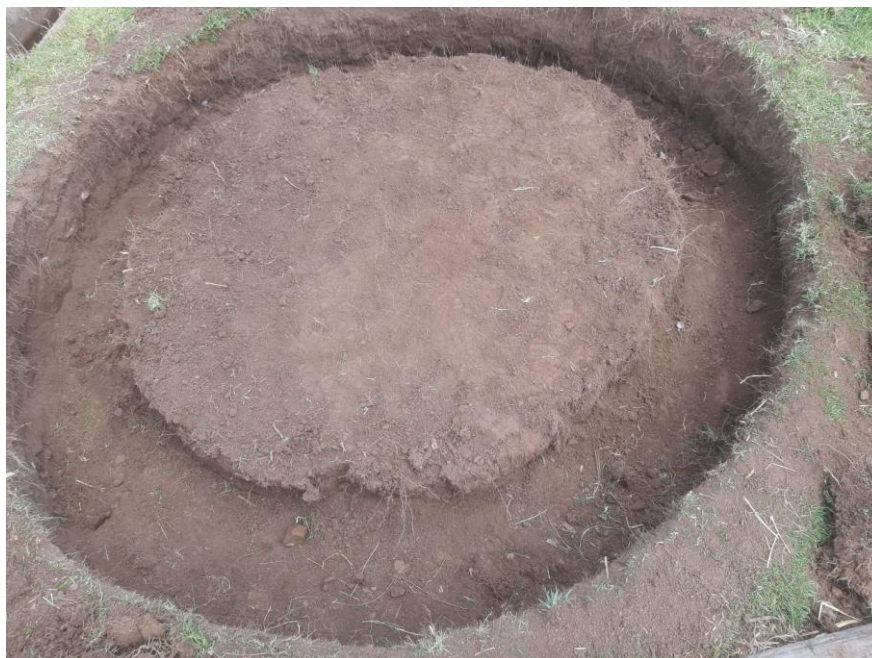
Figura 4: Excavación de la zanja de la cimentación (fuente propia).
