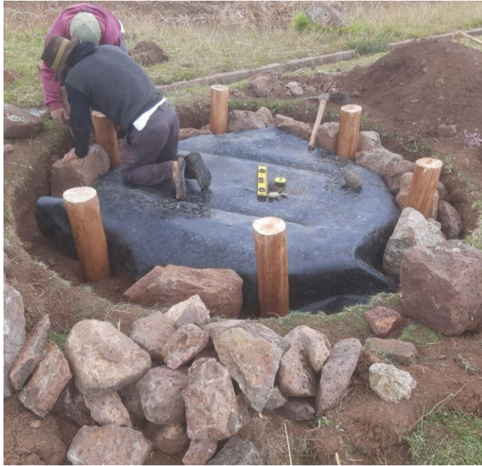
Figura 5: Colocación de la geomembrana (fuente propia).
