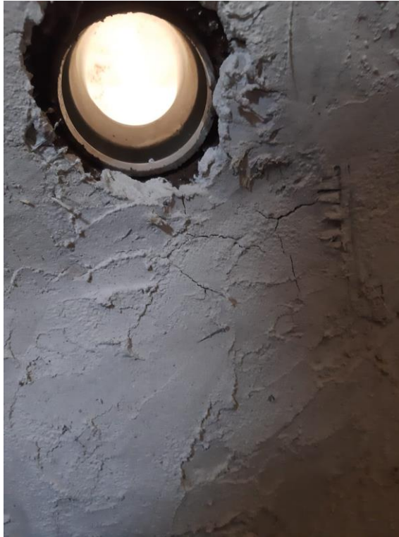
Figura 44: Vista interior del ducto de ventilación (fuente propia).
