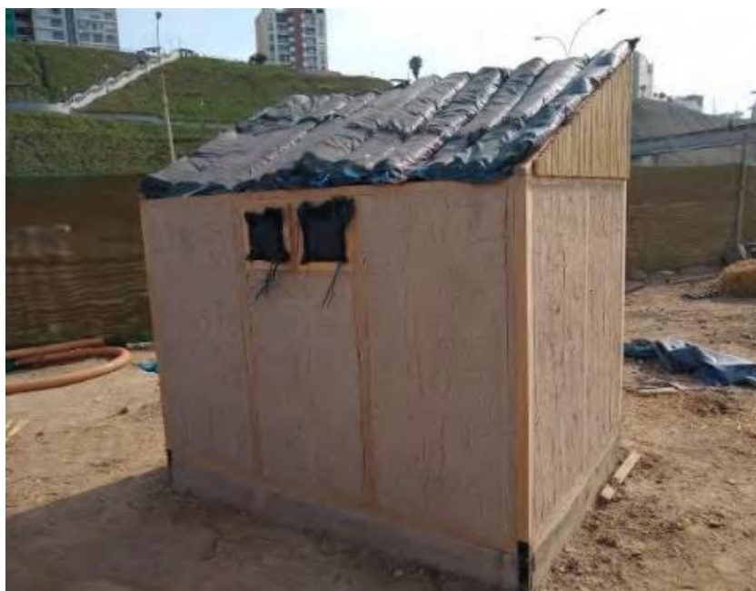
Figura 68: Prototipo a base de quincha y botellas (Fuente: Mestanza, 2021).
