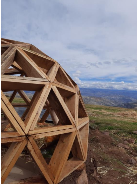
Figura 20: Estructura del domo geodésico (fuente propia).
