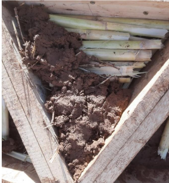
Figura 42: Vaciado de tercera capa de barro y paja (fuente propia).
