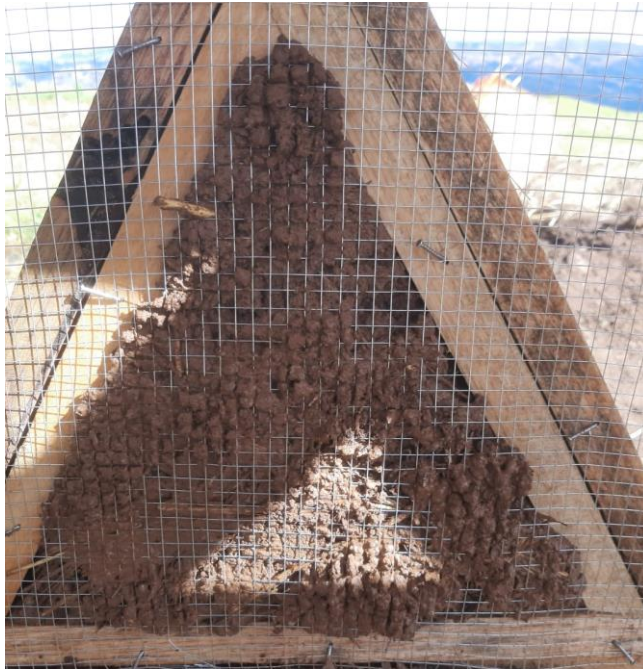
Figura 40: Vaciado de la primera capa (fuente propia).
