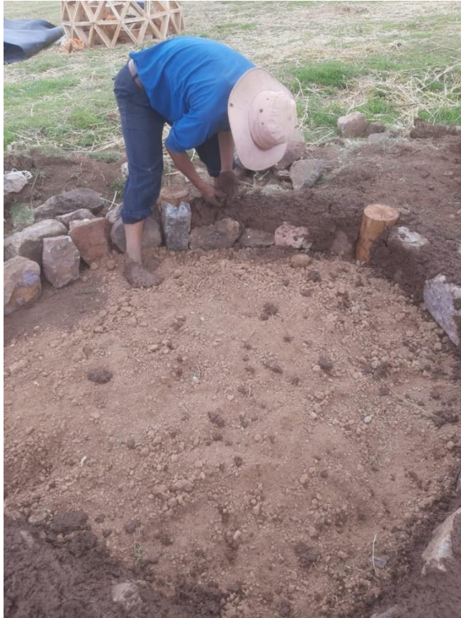
Figura 9: Elaboración del sobrecimiento (fuente propia).
