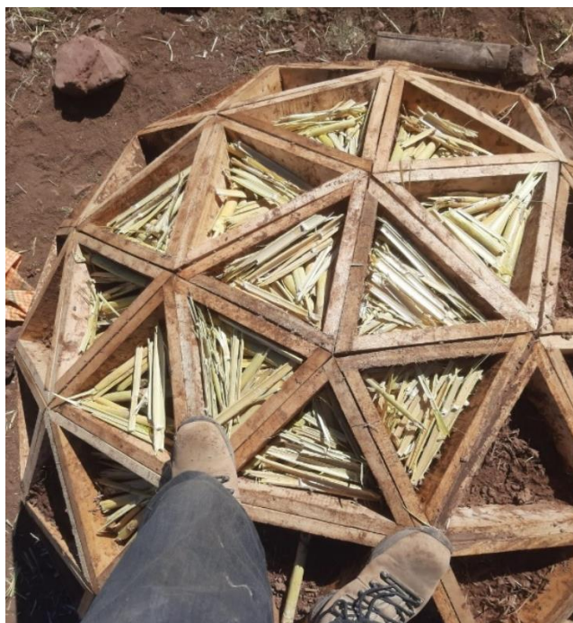
Figura 41: Colocación de la capa de carrizo (fuente propia).
