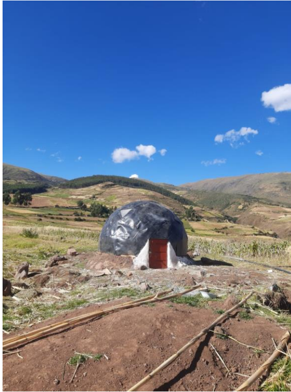
Figura 48: Vista final del prototipo (fuente propia).
