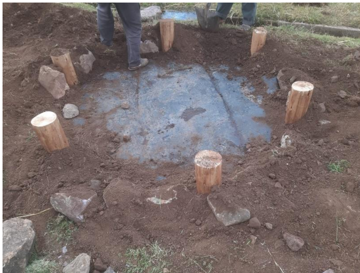
Figura 6: Terminado del pircado de piedra para cimentación (fuente propia).
