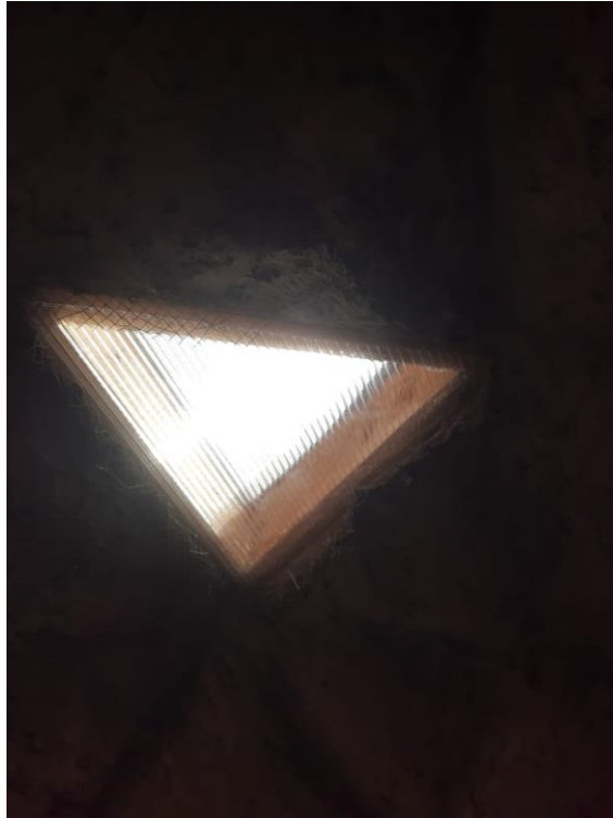
Figura 46: Vista interior de la ventana (fuente propia).
