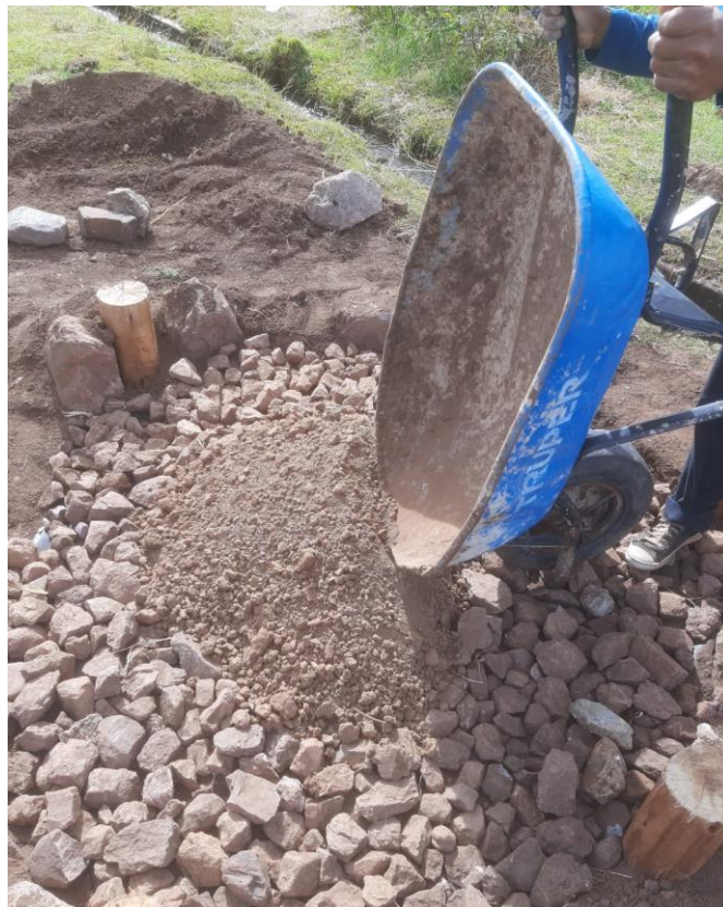
Figura 8: Vaciado de tierra para el piso (fuente propia).
