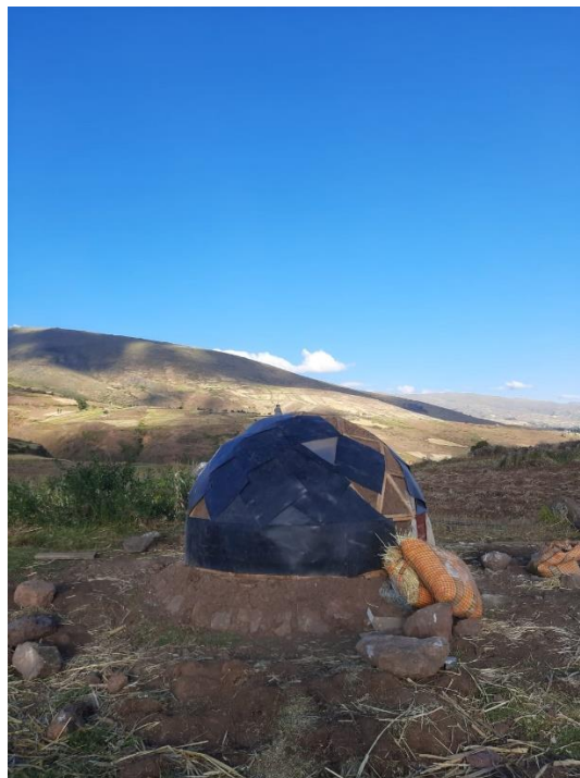
Figura 47: Colocación la capa escamada (fuente propia).
