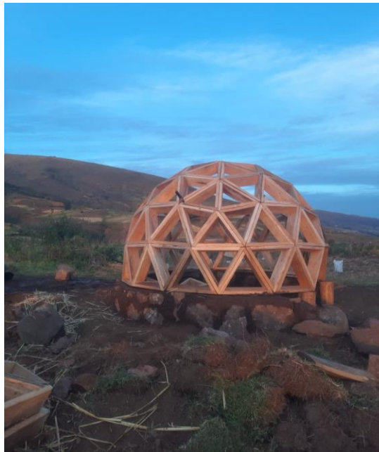
Figura 19: Armado del domo geodésico (fuente propia).
