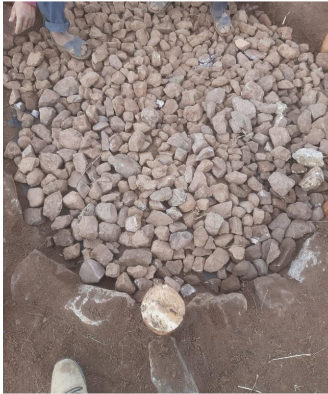
Figura 7: Cama de piedra de 4 pulgadas (fuente propia).
