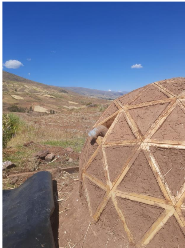
Figura 43: Colocación del ducto de ventilación (fuente propia).
