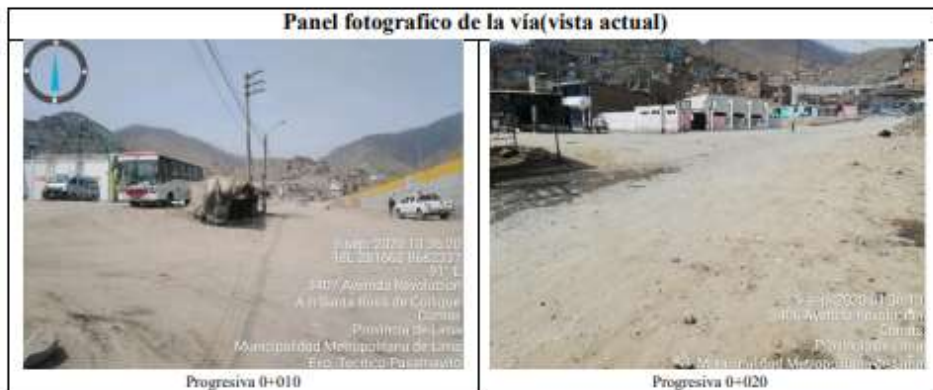
Figura N°6: PANEL FOTOGRÁFICO DE LA VÍA EXISTENTE – ZONA INICIAL
