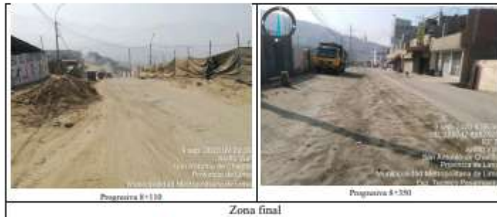
Figura N°8: PANEL FOTOGRÁFICO DE LA VÍA EXISTENTE – ZONA FINAL
