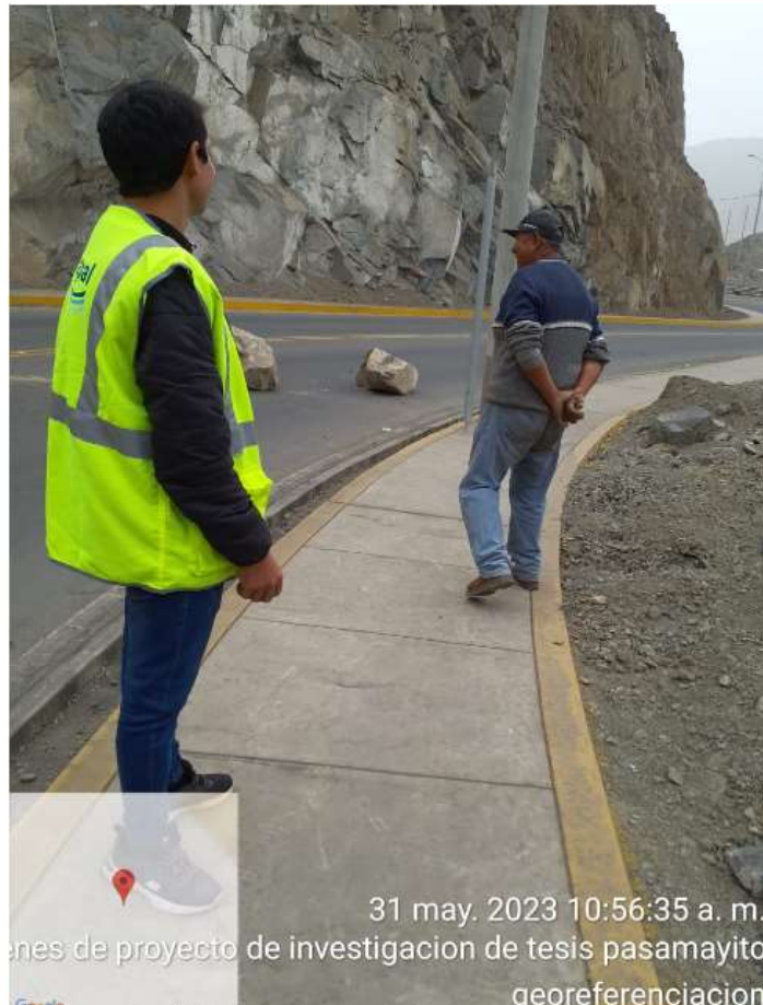
Figura 6. Caída de rocas del talud inestable
