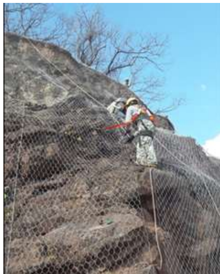
Figura 11. Tendido de malla geosintético.
