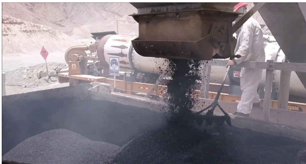
Figura N° 01. Se visualiza la mezcla asfáltica en caliente puesta en obra.
