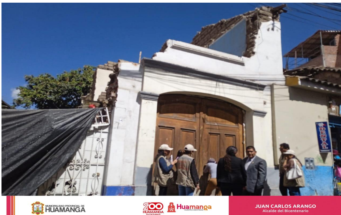
Figura 26: Paralización y sanción administrativa por demolición de casona en el CHH por la unidad de fiscalización y control de la Municipalidad provincial de Huamanga.
