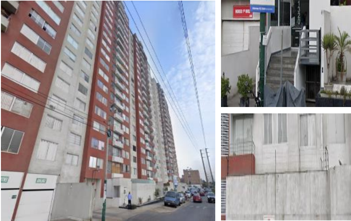
Figura 42. Condominio Paseo el Mirador II (aspectos de accesibilidad, infraestructura y seguridad)
