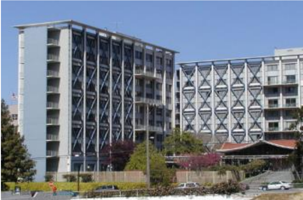
Figura 24. Edificio Residence Hall, Berkely, Estados Unidos, rehabilitado con riostras de acero. (Sistemas sismorresistentes)
