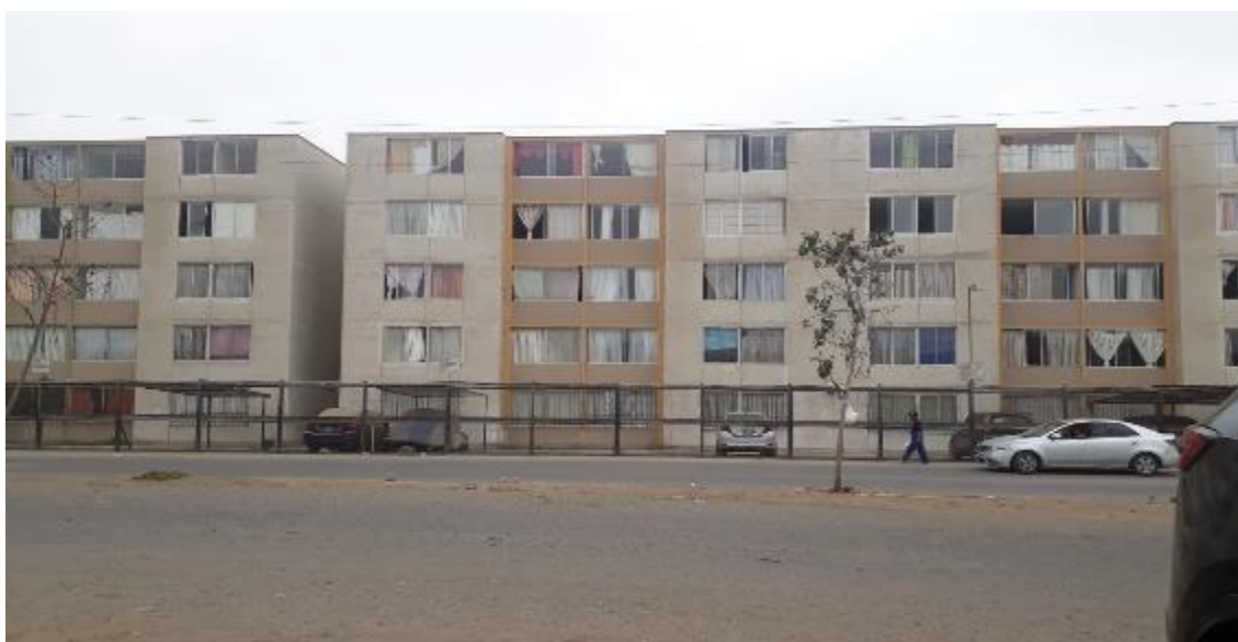
Figura 36. Condominio los parques de Villa el Salvador
