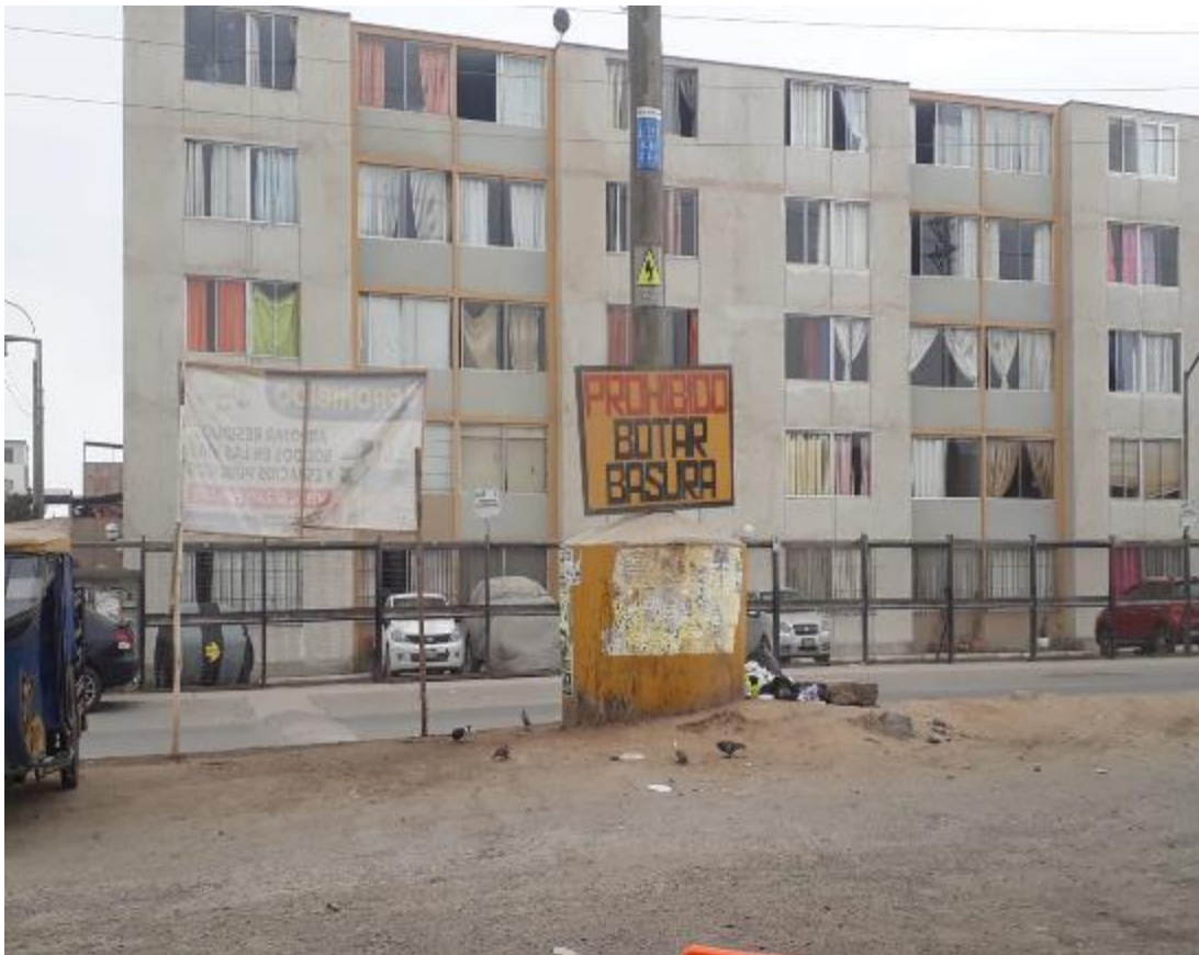
Figura 56. Condominio los parques de Villa el Salvador
