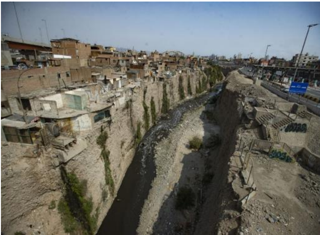
Figura 8. Vista aerea de viviendas tugurizadas al borde del Rio Rimac
