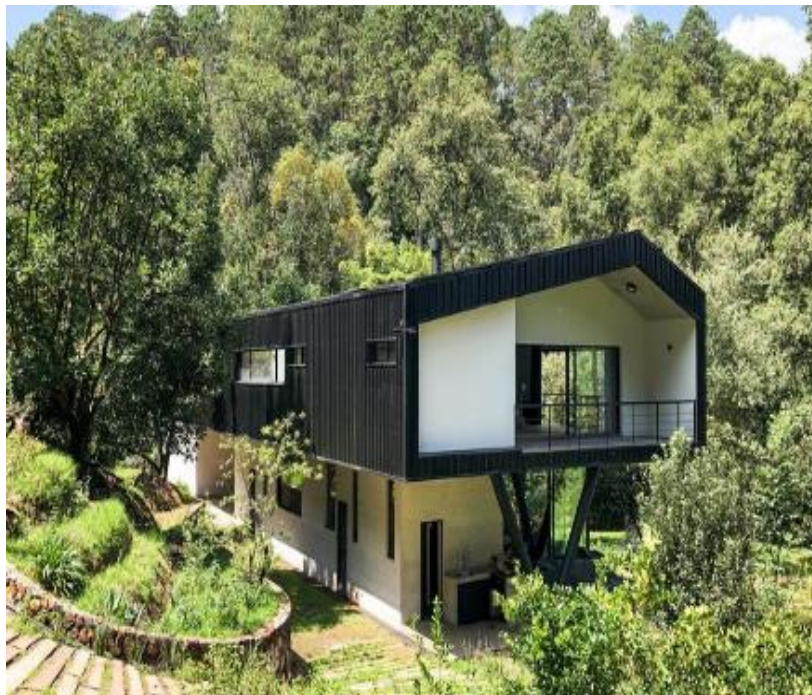
Figura 10. Casa Ocoxal por A-001 Taller de Arquitectura, vivir en la naturaleza, Pueblo de Valle Bravo, ciudad de México
