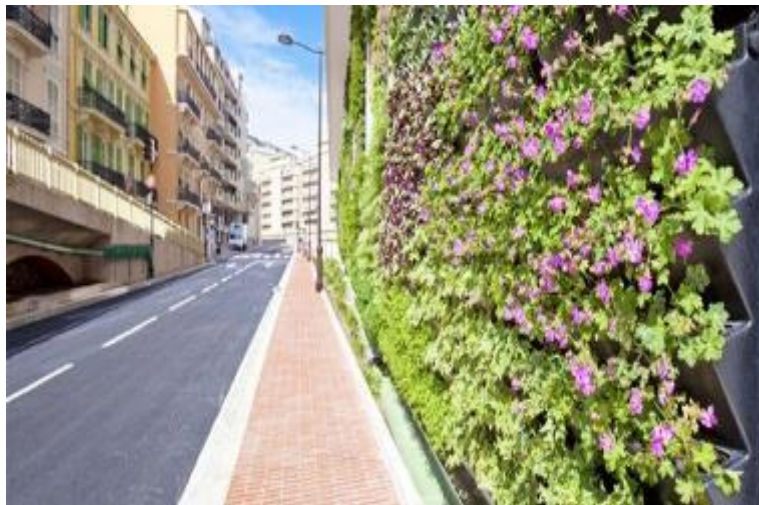
Figura 22. Muros verdes, como aislantes del ruido
