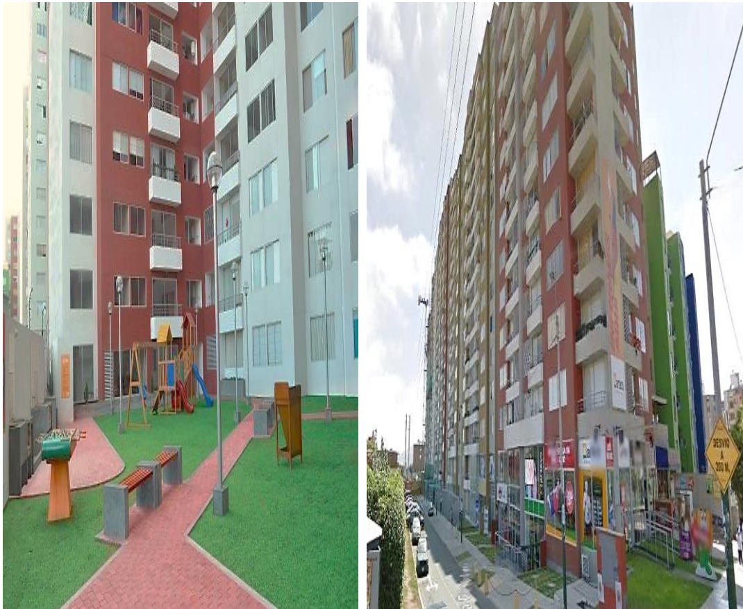
Figura 52. Condominio Paseo el Mirador II (características de la habitabilidad)
