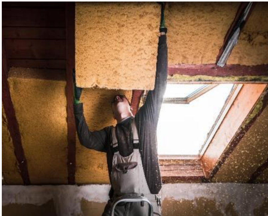
Figura 18. Instalación de panel aislante térmico de fibra de madera
