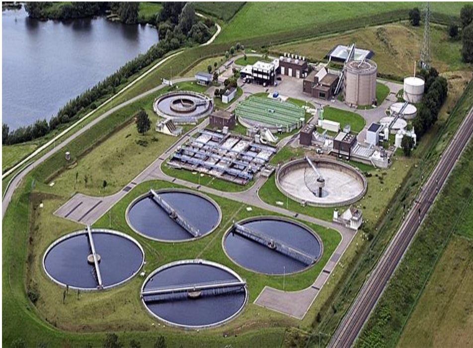
Figura 12. Vista aérea de una planta de tratamiento de aguas residuales
