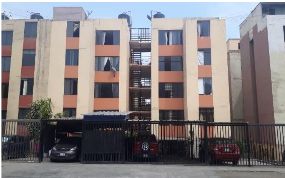
Figura 46. Condominio los parques de Villa el Salvador
