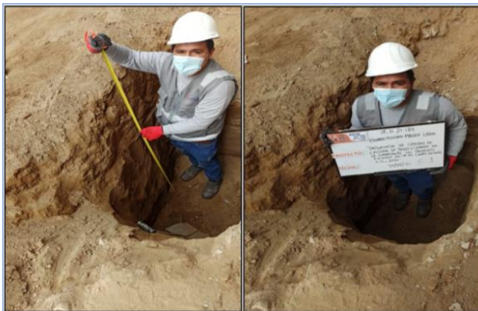
Figura 16. Excavación de calicatas in situ: C – 01 y C – 02
