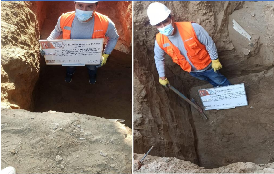
Figura 17. Excavación de calicatas in situ: C – 03 y C – 04
