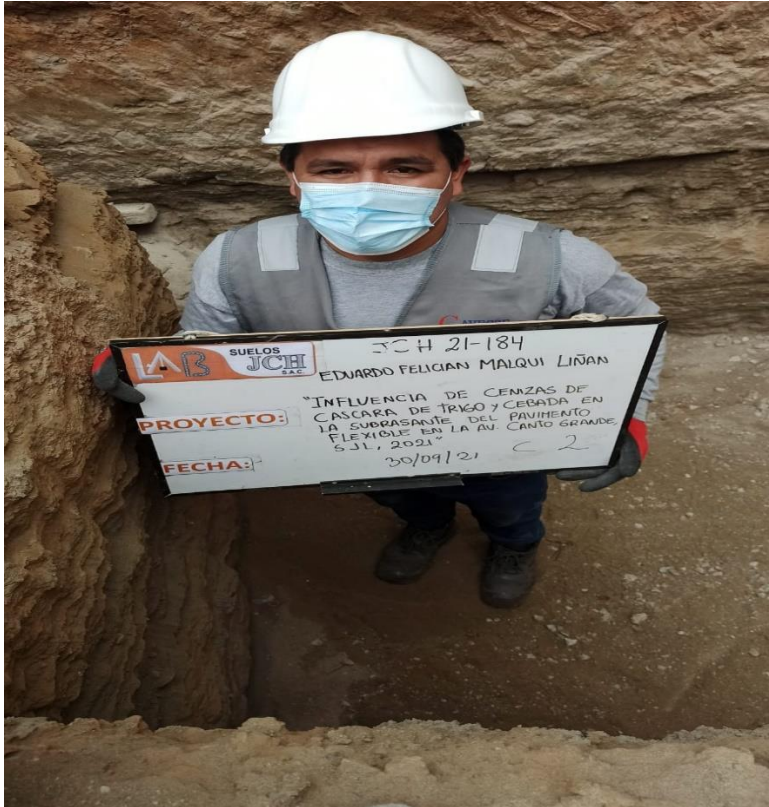
Ubicación de la calicata C-02
