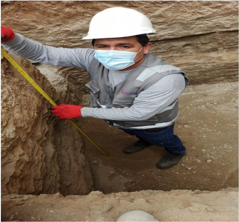
Profundidad de la calicata C 01
