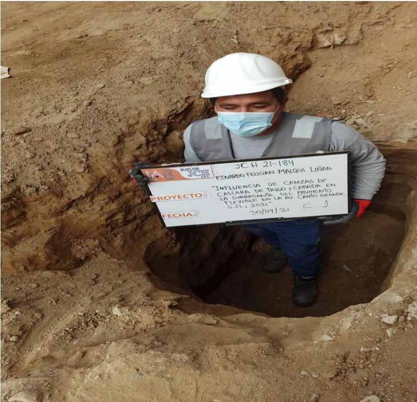
Ubicación de la calicata C-01
