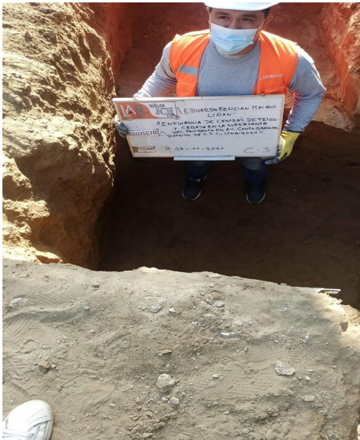
Ubicación de la calicata C-03
