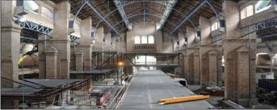
Figura 62: Remodelación del Mercado de Sants
