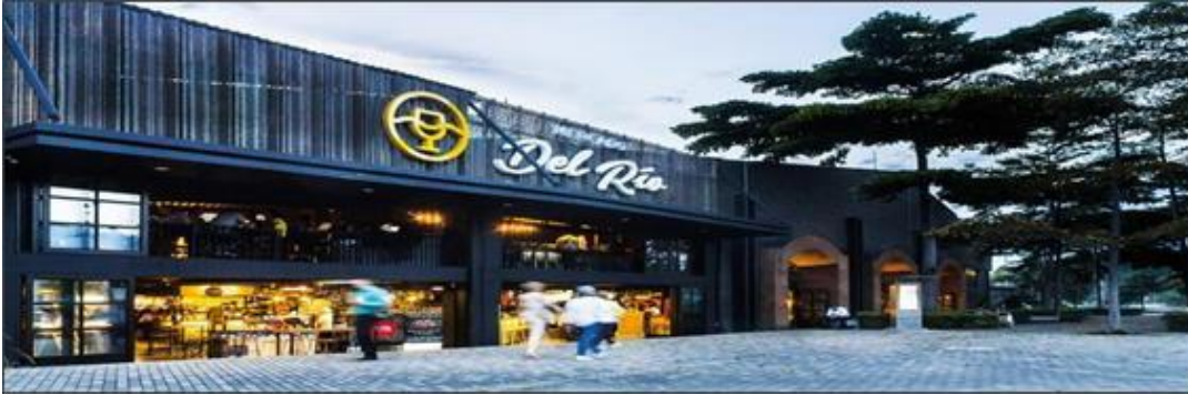
Figura 48: Fachada del Mercado del Río
