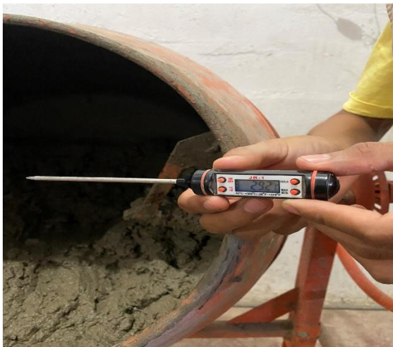
Fotografía N°22: Toma de temperatura del concreto.
