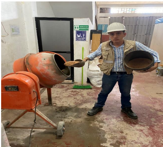
Fotografía N°20: Elaboración de concreto con aserrín.
