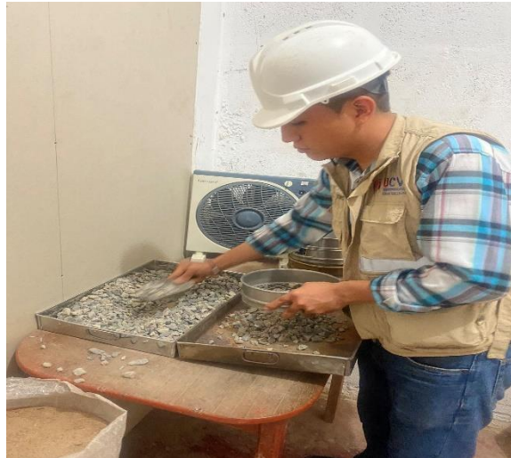
Fotografía N°07: Tamizado del agregado grueso.
