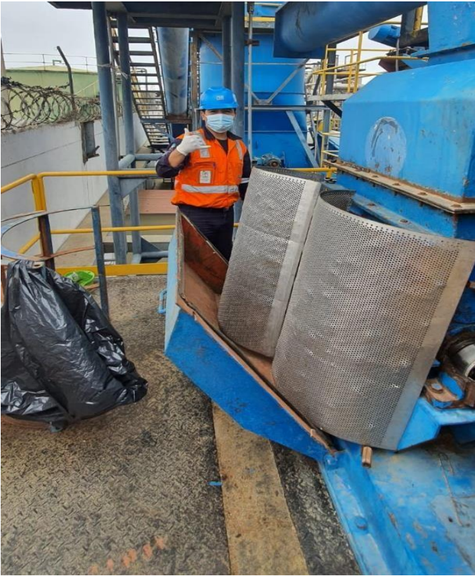
5. Revisión de molinos en mantenimiento autónomo.
