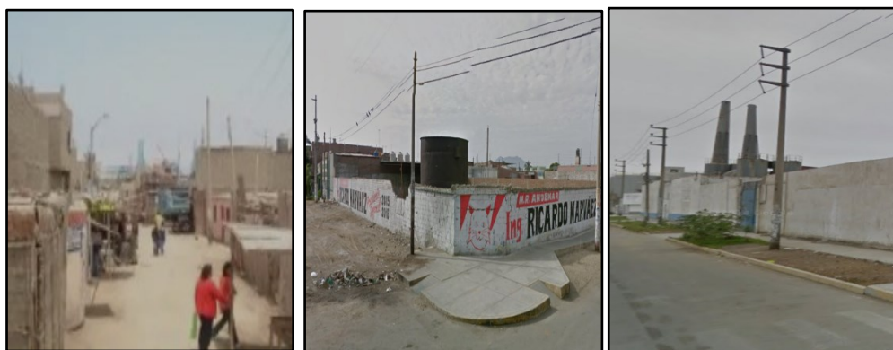
Figura N° 06: Imágenes de equipamientos Av. Junín - Av. Moquegua (2002) - Sector Florida Baja.
