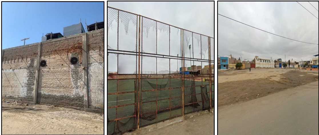
Figura N° 26: Moquegua - Av. Costanera - Av. Huancavelica - Sector Florida Baja
