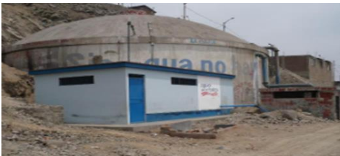
Figura N° 1: Reservorio apoyado, ubicado en Collique
