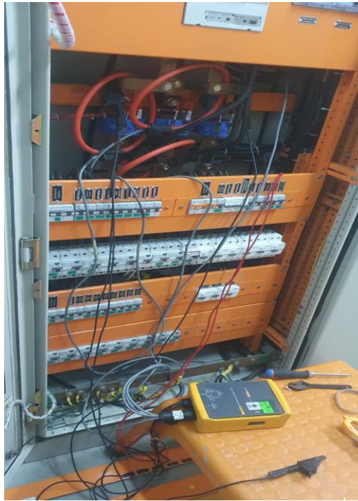
Figura 11: verificación del registro
