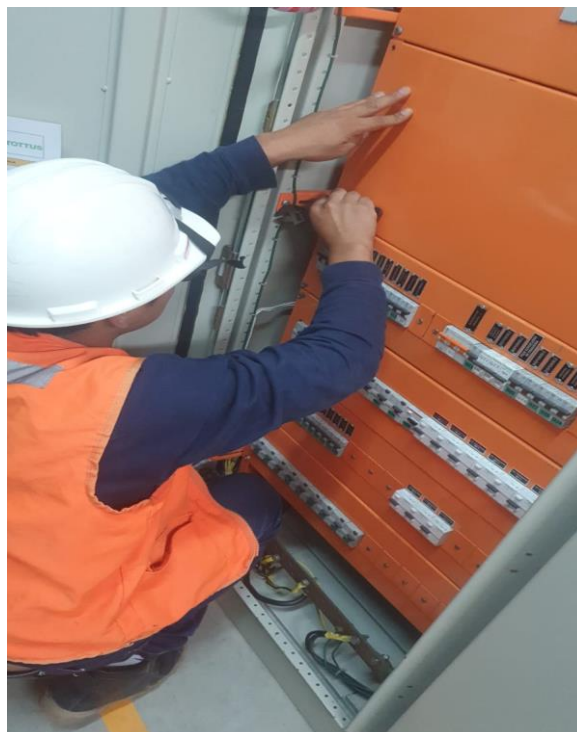
Figura 12: Colocación de tapa interna del tablero.
