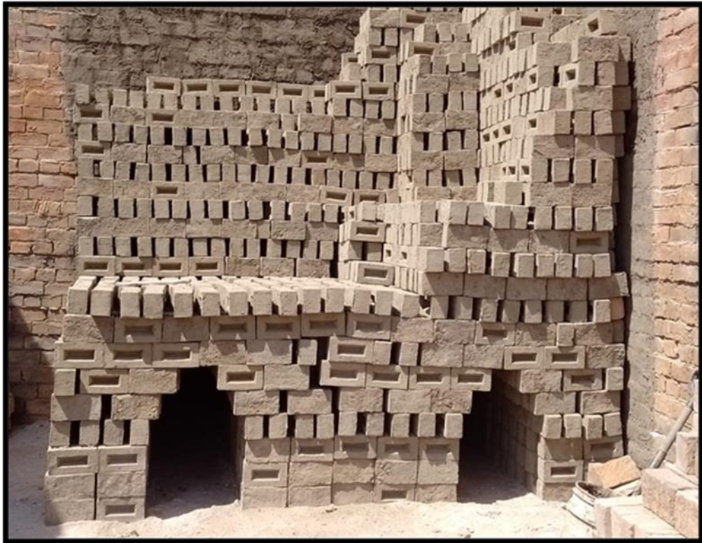
Armado de horno.
