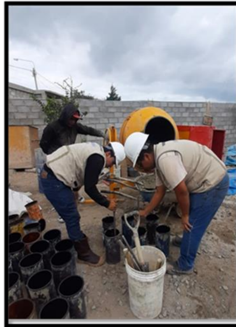
Se procede a vaciar el concreto en 3 capas, se realiza 25 golpes por cada capa.
