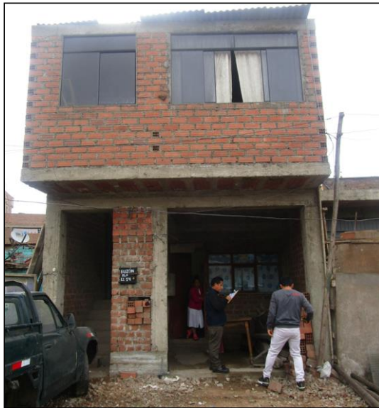
Imagen de la fachada
