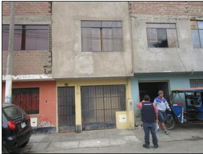
Imagen de la fachada
