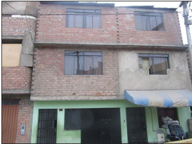
Imagen de la fachada
