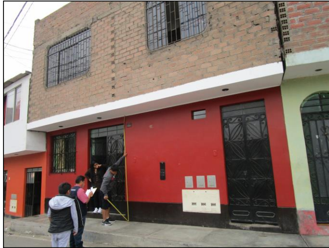
Imagen de la fachada
