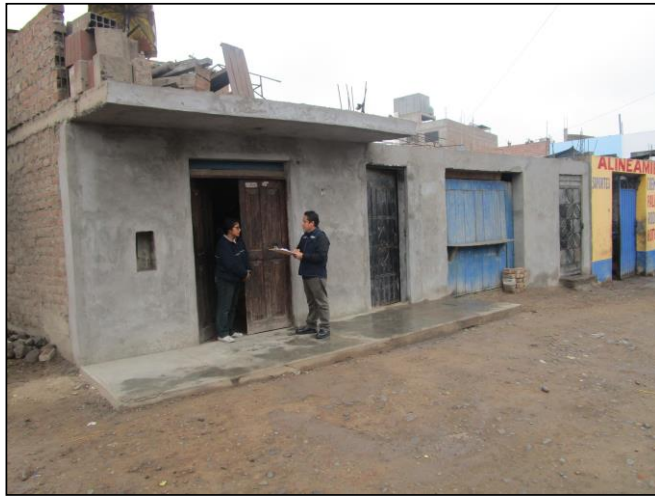
Imagen de la fachada
