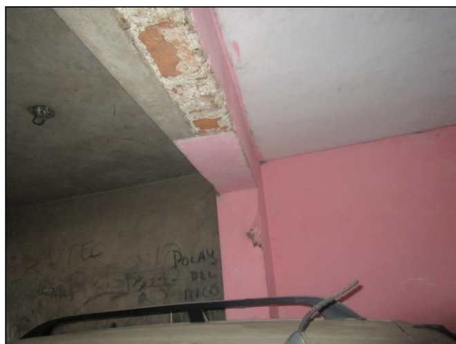
Muro portante demolido en primer piso
