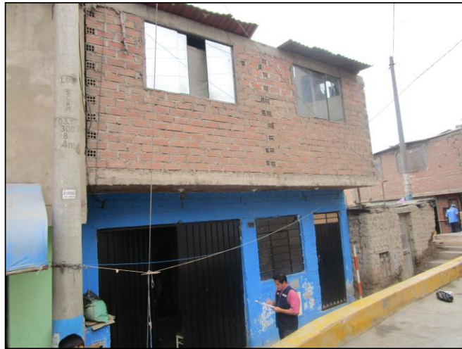
Imagen de la fachada
