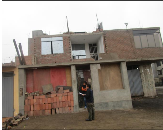
Imagen de la fachada
