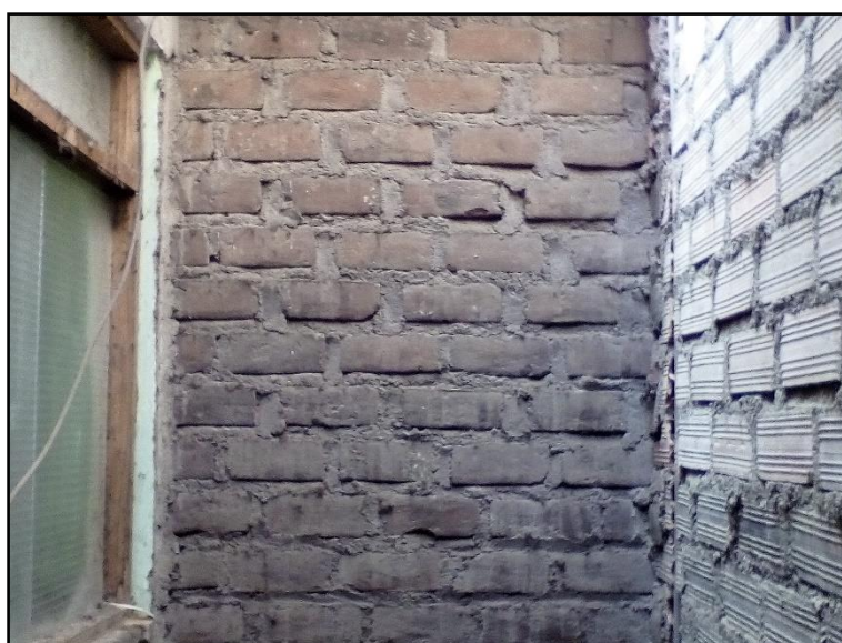
Figura 3.15 – Los ladrillos artesanales no tiene dimensiones uniformes (Fuente: Elaboración propia)
