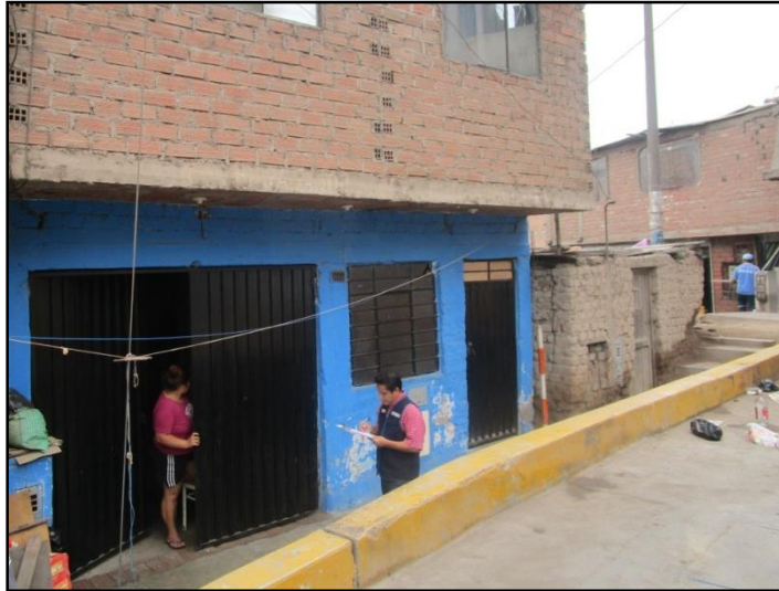
Figura 3.2 – Vivienda sobre relleno para tratar de alcanzar el nivel de la vía (Fuente: Elaboración propia)
