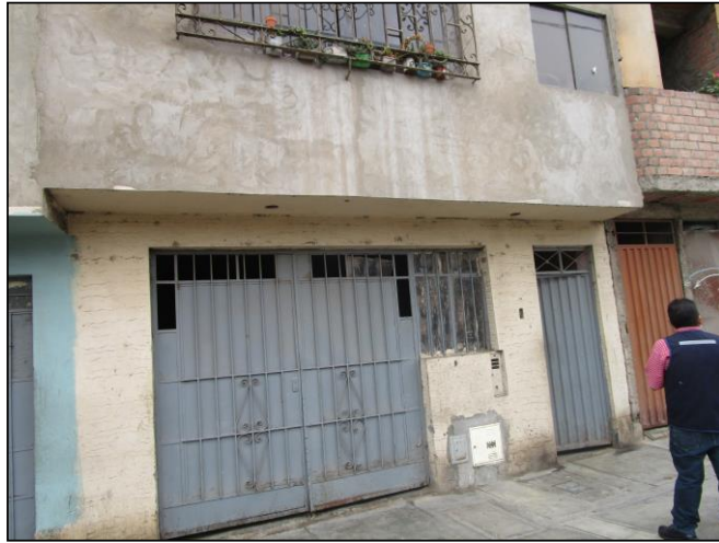
Imagen de la fachada
