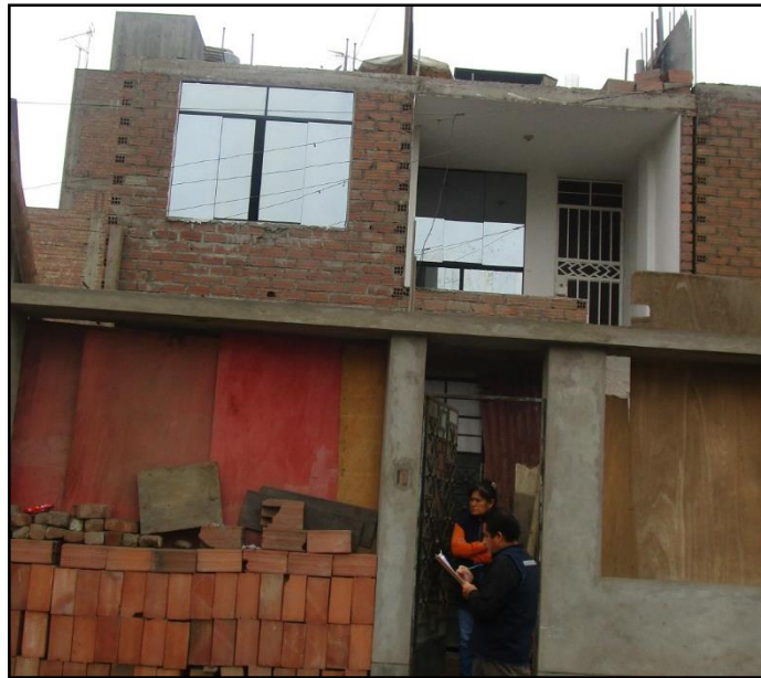
Figura 3.8 – Ladrillo pandereta utilizado en muro portante de segundo piso(Fuente: Elaboración propia)
