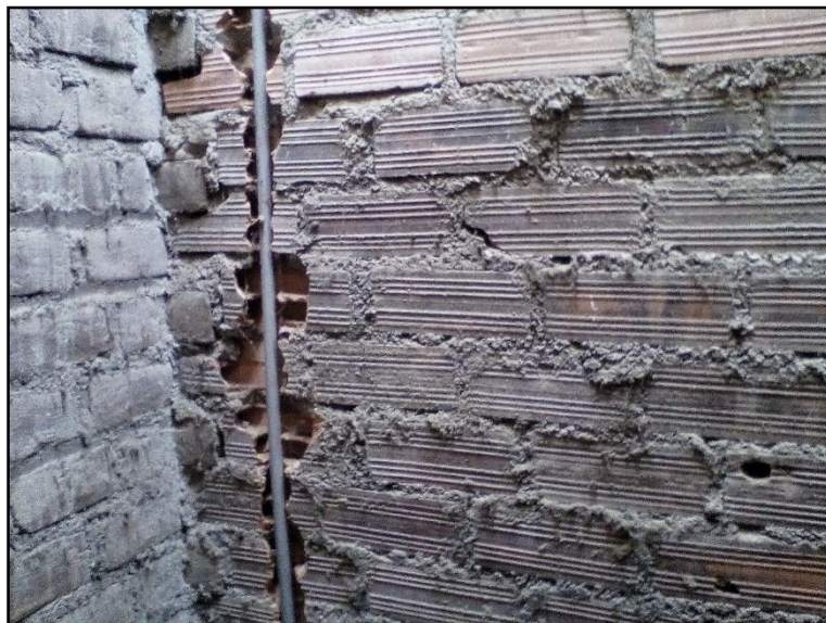
Figura 3.19 – Tubería PVC de agua expuesta (Fuente: Elaboración propia)
