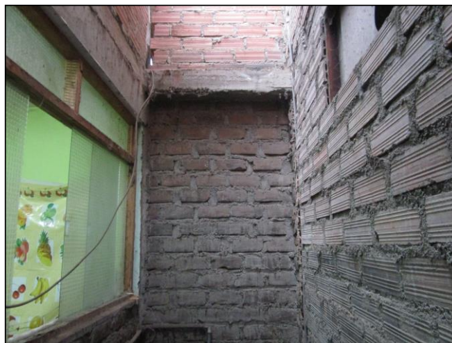
Juntas en muros mayores a 1.5 cm.
