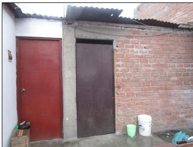
Muro portante con ladrillo pandereta en 3° nivel
