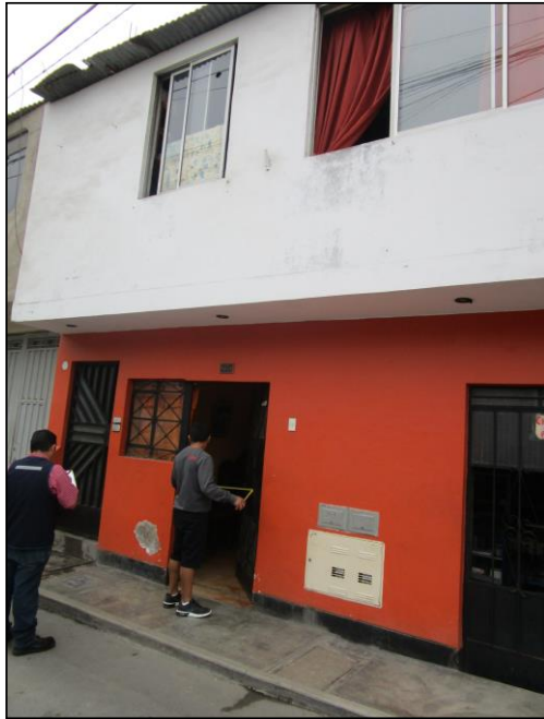
Imagen de la fachada
