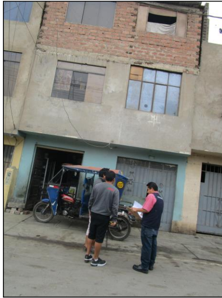
Imagen de la fachada
