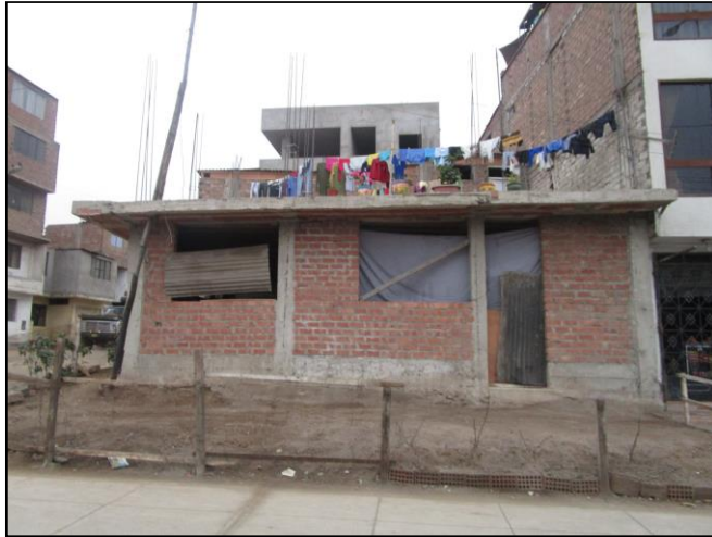
Imagen de la fachada
