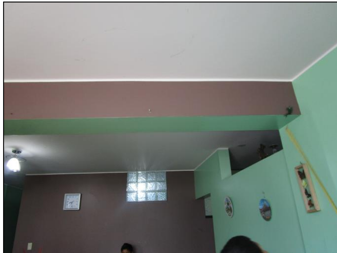
Muro y cielo raso revestidos
