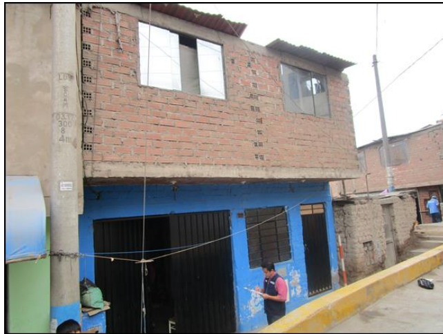
Imagen de la fachada
