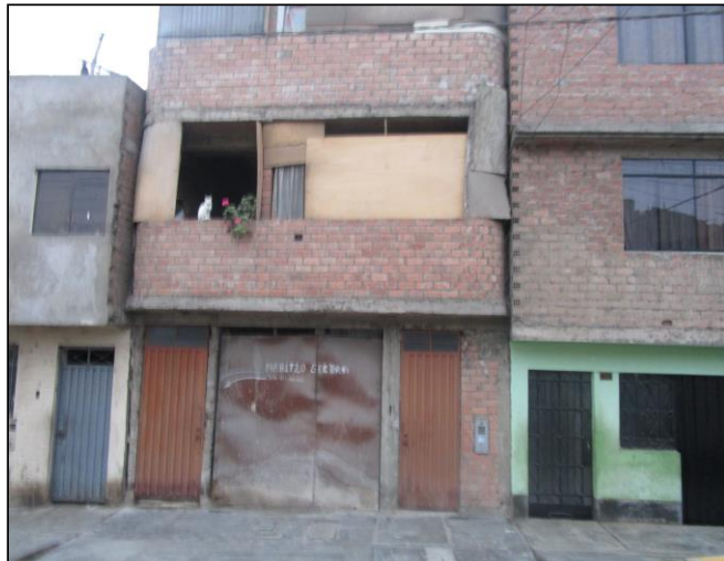
Imagen de la fachada
