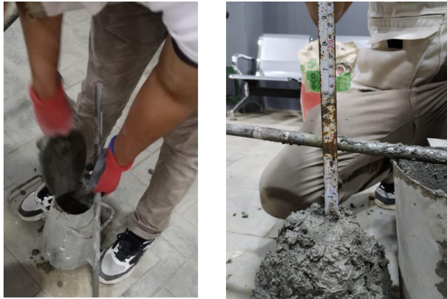
Figura 10. Prueba Slump (Cono de Abrams).
