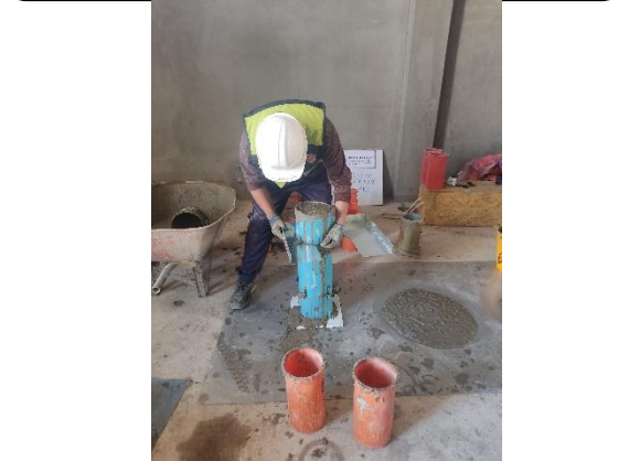
FOTO 53: EXTRAENDO PARTE SUPERIOR E INFERIOR DE COLUMNA DE SEGREGACION
