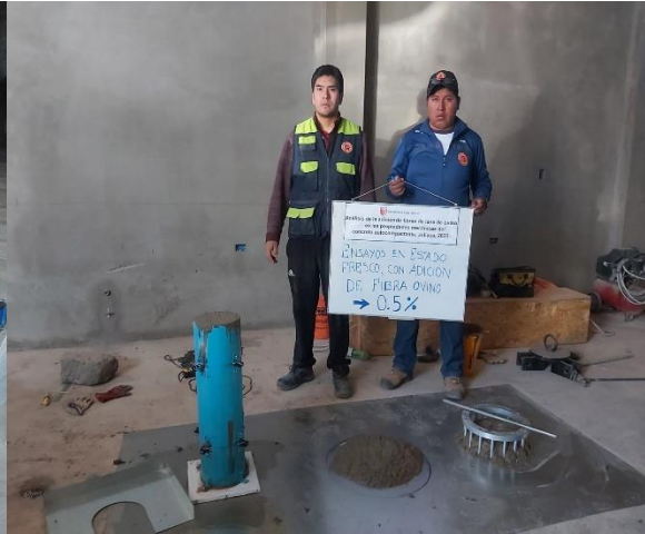
FOTO 50: PRUEBA CON ADICION DE FIBRA
