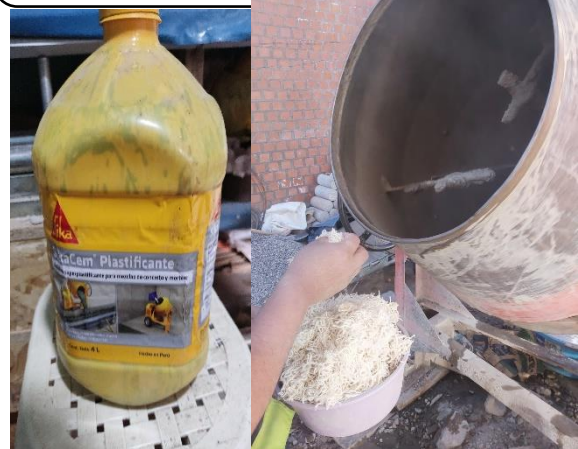
FOTO 46: USO DE SIKACEM PLASTIFICANTE Y FIBRA DE OVINO
