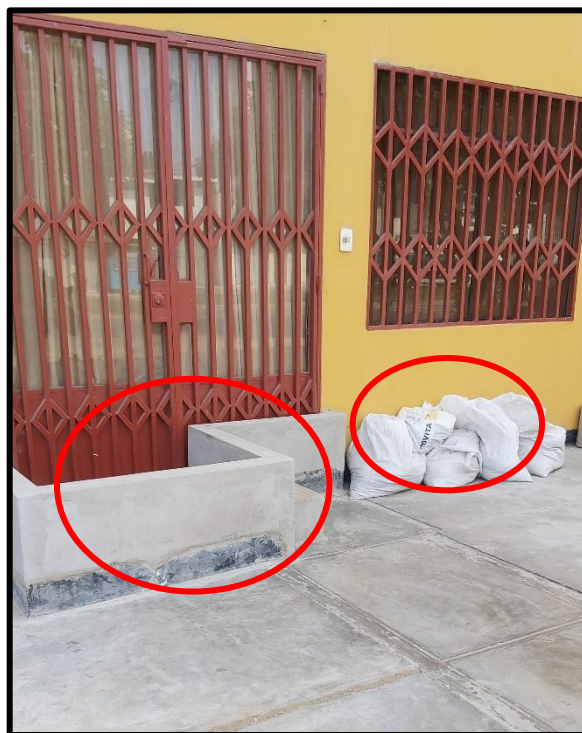
Foto 3. Entrevistando a la población y ellos mismos resguardan sus casas como costales y construyendo muros para evitar las inundaciones.
