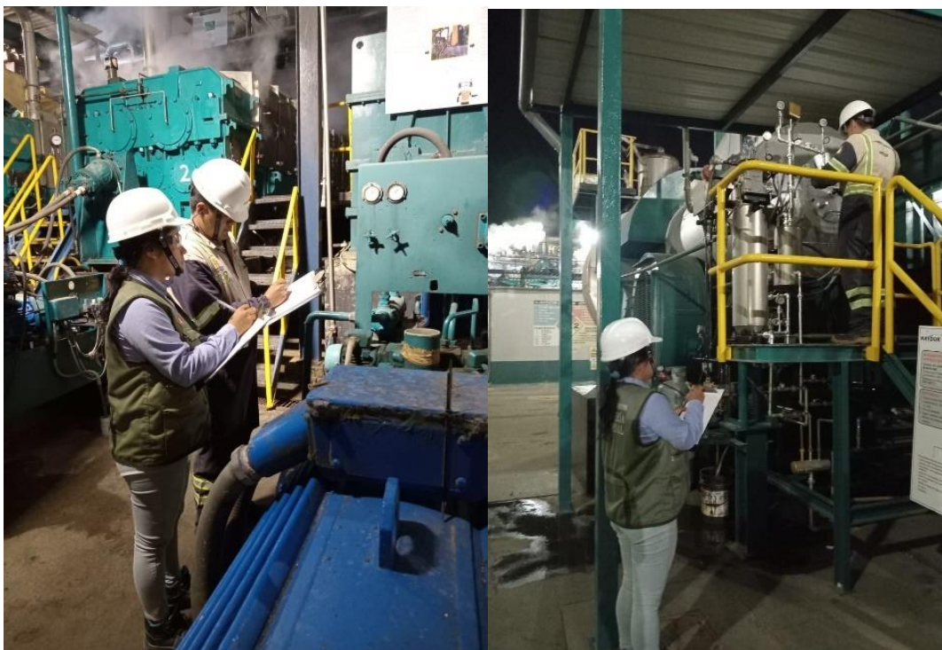
Figura 24: DAP – Inspección de Mantenimientos preventivos - Cocina Elaboración propia
