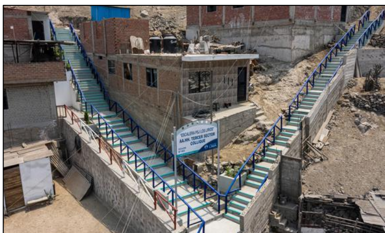
Figura 3 Escaleras de accesibilidad
