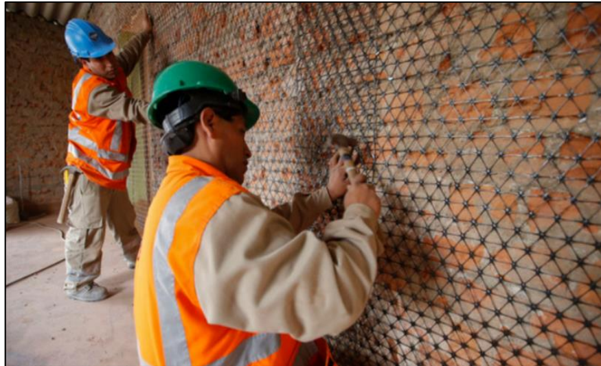
Figura 2 Malla de reforzamiento estructural
