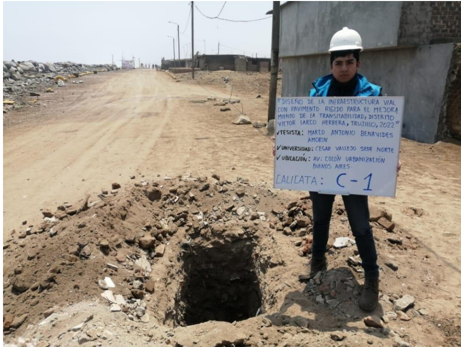
FOTOGRAFÍA N° 1. Vista general de la Calicata C-01.
