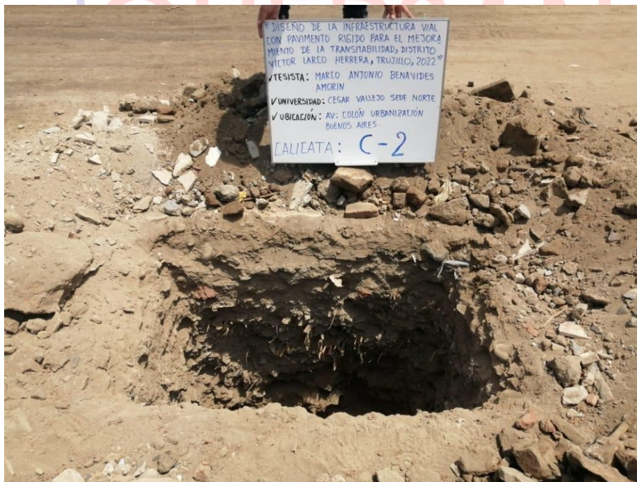
FOTOGRAFÍA N° 2. Vista general de la Calicata C-02.
