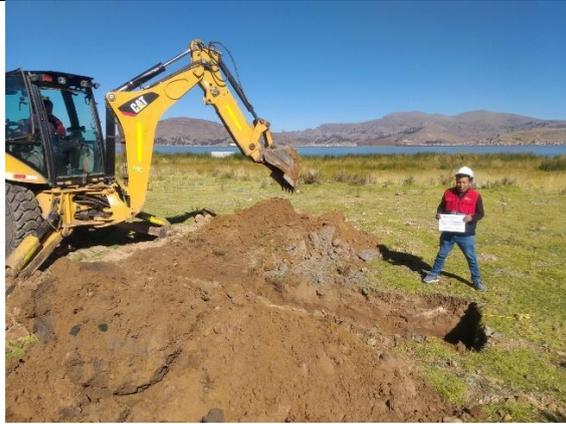
**Fotográfica 1:** Excavación de calicatas
