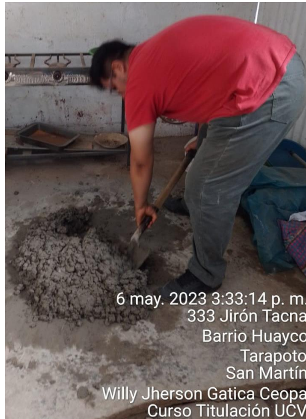
Foto 17: elaboración del concreto, se realizó para cada tipo de agregado grueso.
