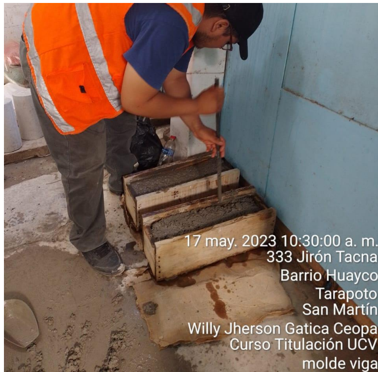
Foto 21: colocación del concreto en los moldes de viga.
