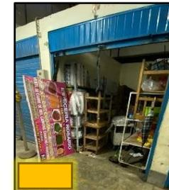
Teniendo como referencia al puesto N°2 pabellón 7, se puede observar que la pintura de las paredes y el exterior está cuarteada, también tiene ventanas de marco de metal la cual presenta corrosión. (18%)
