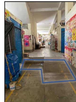
A lo largo de todos los pasillos verticales, se observan escaleras de 2 gradas y rampas de medidas de 1.00m y 2.00m de ancho que a su vez se observan interrumpidas por productos de los comerciantes.
