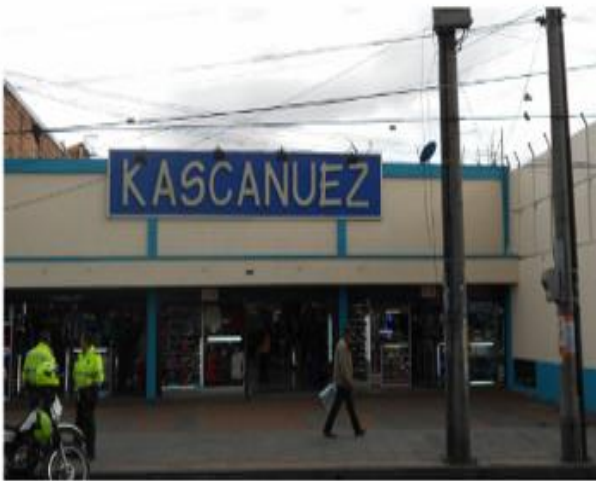
Imagen 2. Pasaje comercial construido en los años noventa dedicado a venta de ropa
