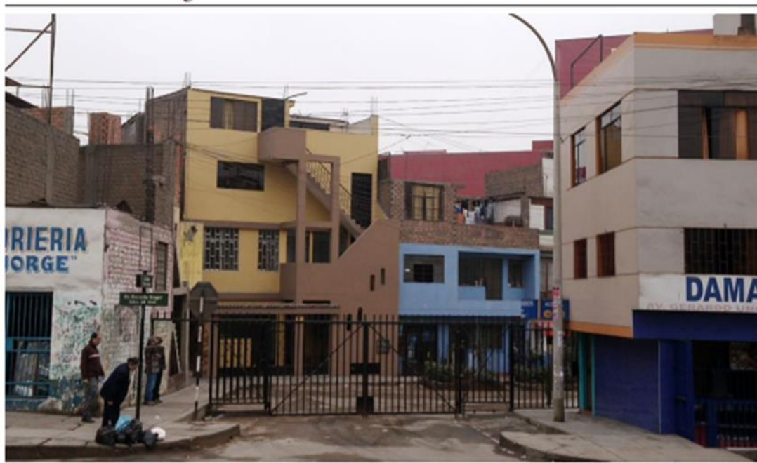
Figura 2 Barrera arquitectónica - transitabilidad interrumpida
