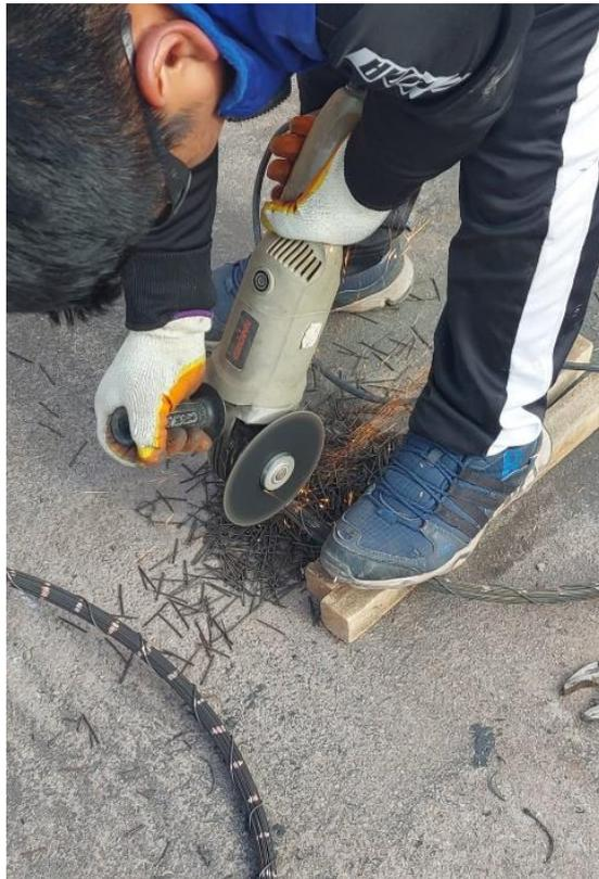
Se visualiza el cortado del acero del neumático
