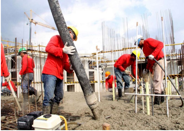
Figura 6. Actividad en obra de Construcción: Vulnerabilidad
