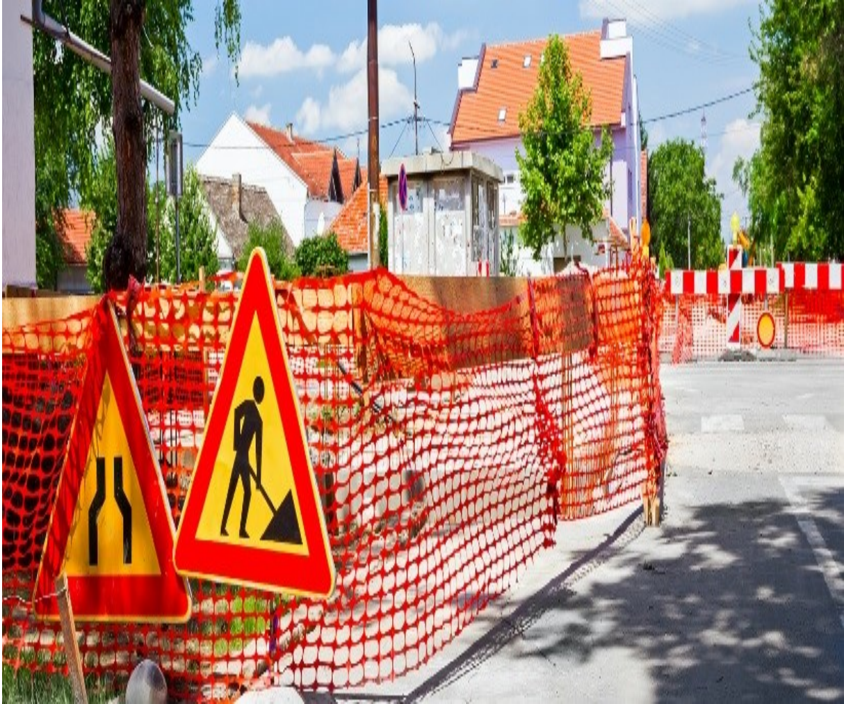
Figura 5. Actividad en obra: Señalización en las áreas de trabajo
