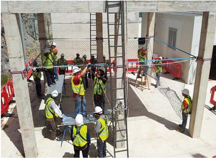
Figura 9. Actividad en obra de construcción
