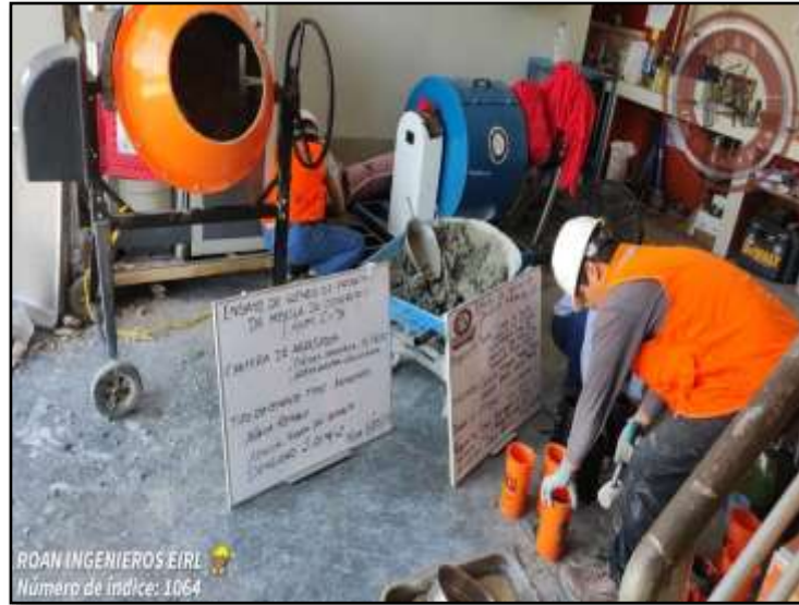
Figura N°07: Elaboración de probetas para el ensayo a compresión
