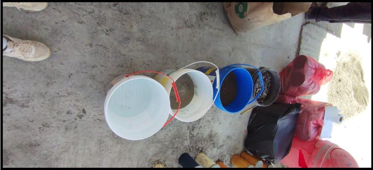
Dosificación proporcional de los materiales para la mezcla del concreto (agregados, agua y cemento)
