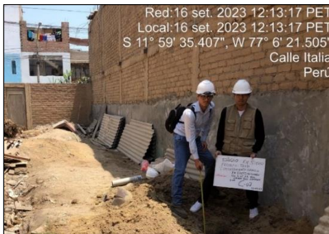
Calicata 02 Fuente: Elaboración propia (2023)
