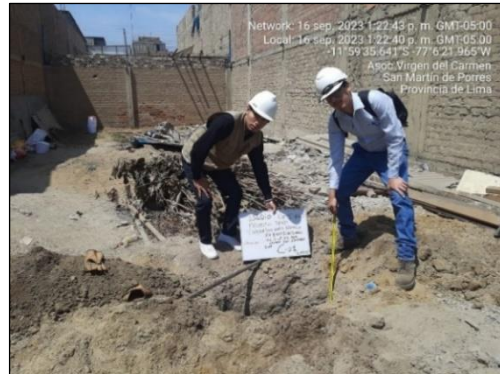
Calicata 01 Fuente: Elaboración propia (2023)
