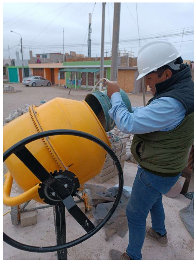
Fotografía 8: preparación de mezcla para unidades de albañilería.
