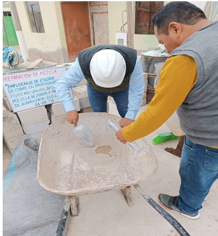
Fotografía 6: preparación de mortero para los dados GROUT.
