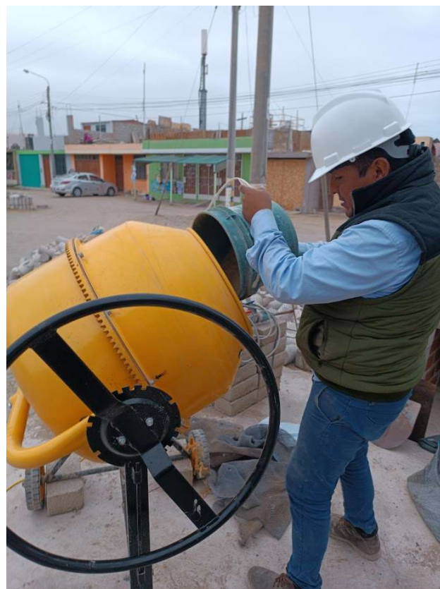
Fotografía 12: preparación de mezcla para unidades de albañilería.
