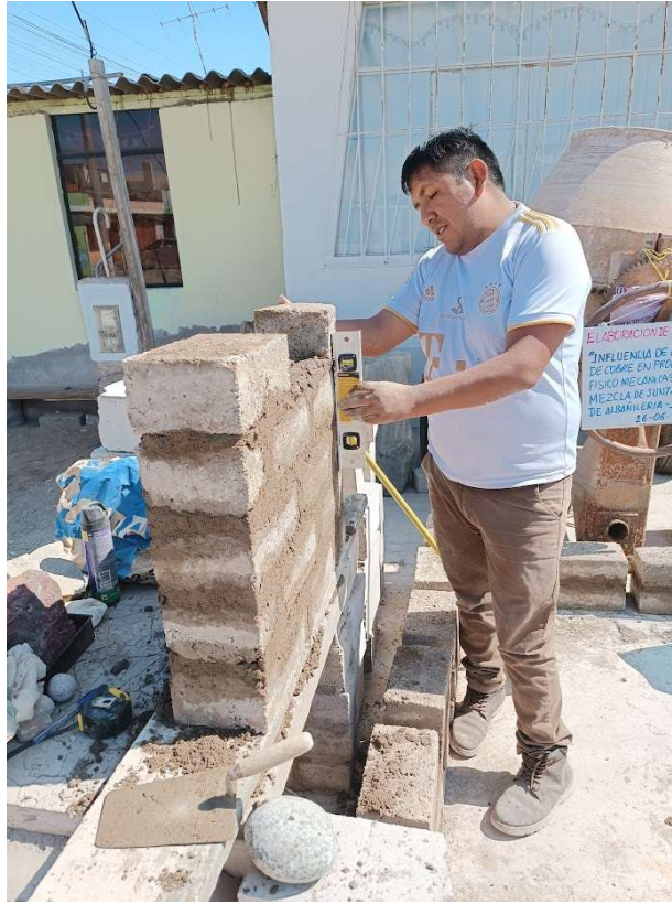
Fotografía 15: elaboración de murete
