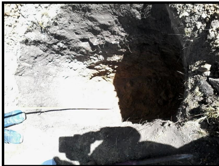
Figura 9 Excavacion toma de muestra representativa de la calicata C-3
