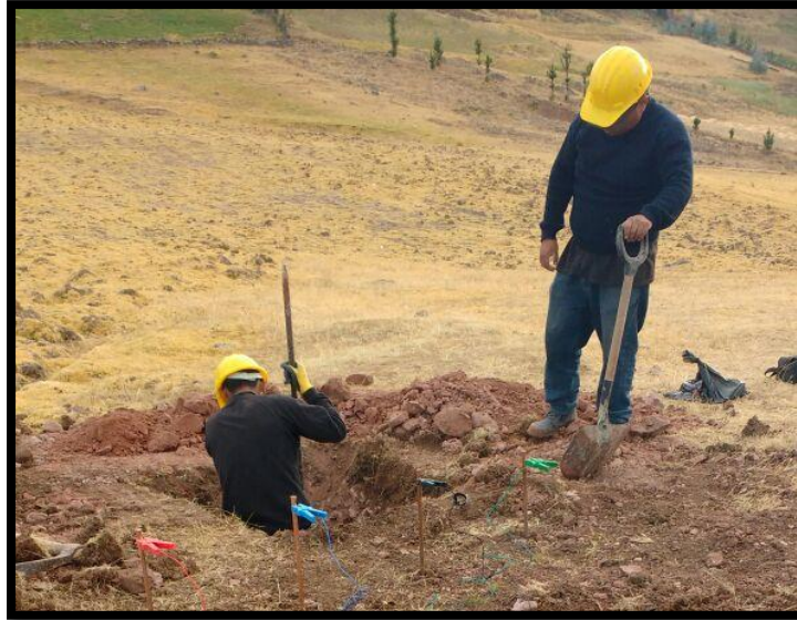
Figura 8 Excavación toma de muestra representativa de la calicata C-2
