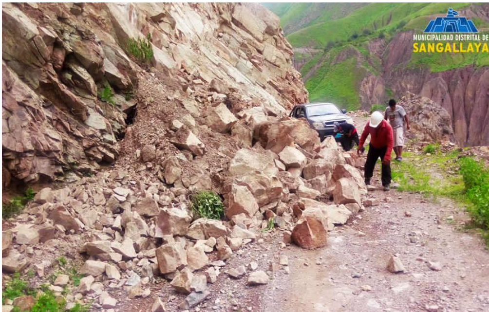
Figura I - 1. Deslizamiento de talud en la zona de Sangallaya
