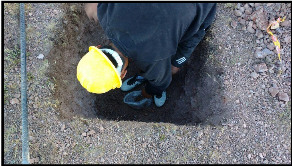
Figura 7 Excavación toma de muestra representativa de la calicata C-1
