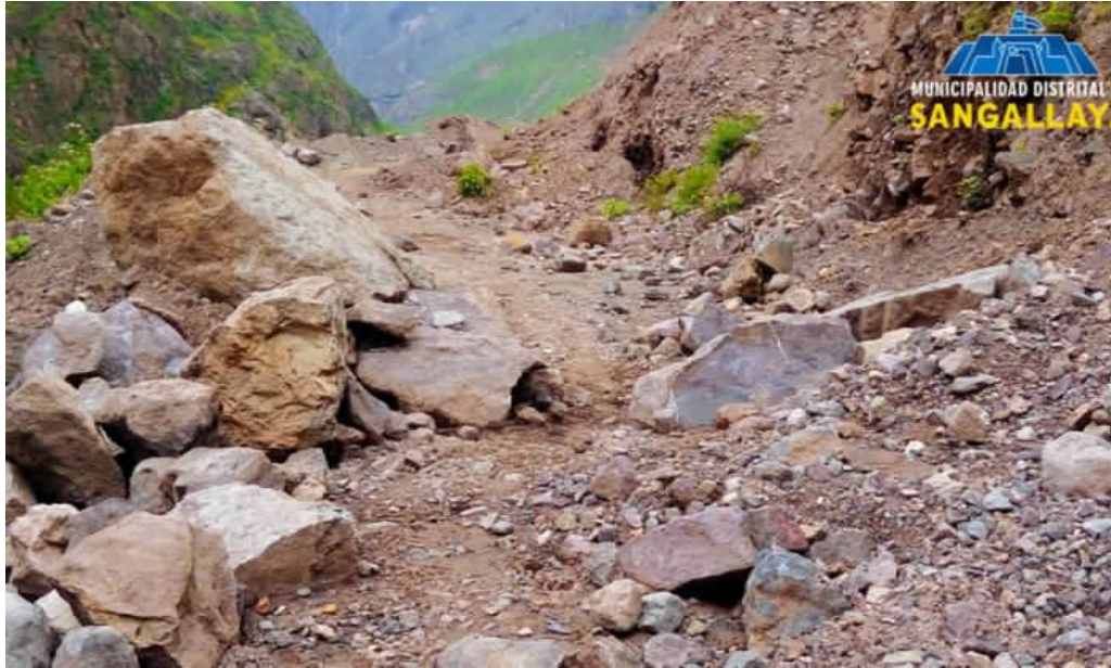
Figura 1 – 2 Deslizamientos de taludes en la zona de Sangallaya
