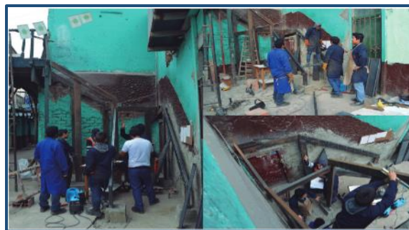
Figura 09: Proceso de armado e instalación de escalera con participación vecinal.
