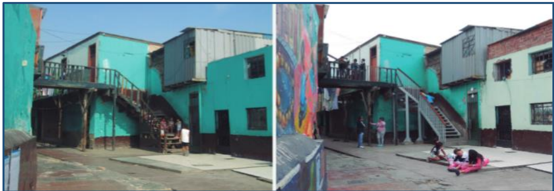
Figura 10: Proceso de armado e instalación de escalera.
