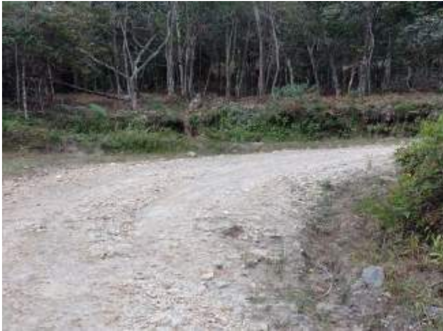
IMAGEN 01: La vía existente no cuenta con señalización.
