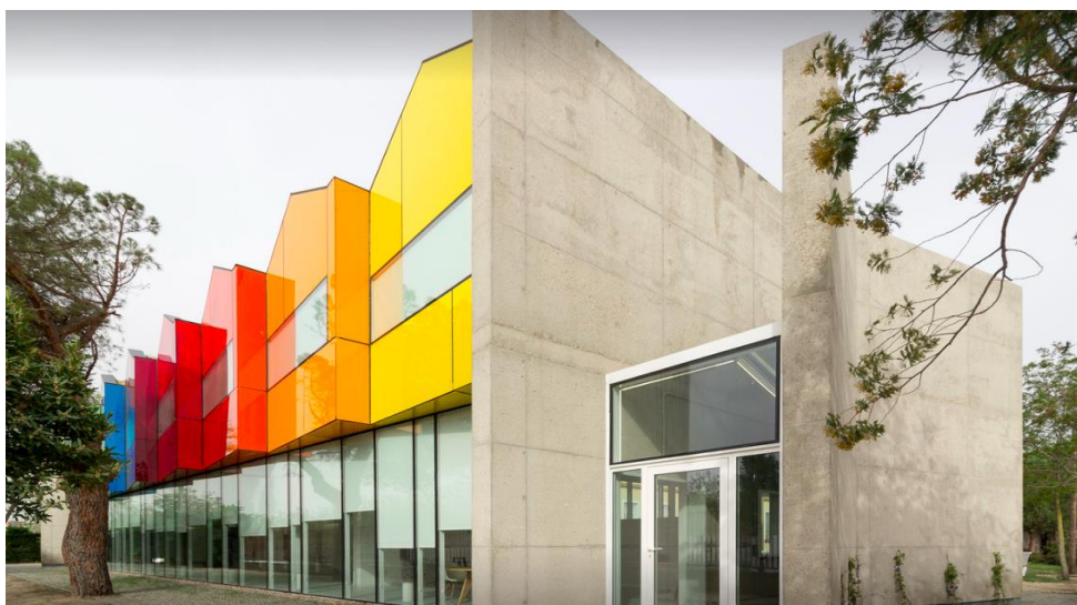
Paneles de vidrio de colores en fachada de la fundación Esther Koplowitz, Madrid.
