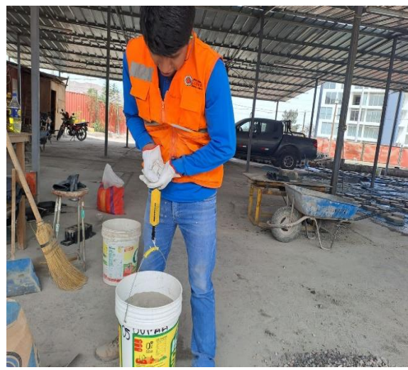
Fotografía N°36. Pesado de cemento según la dosificación.
