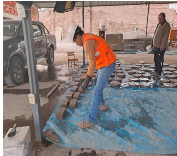
Fotografía N°34. Desmoldado de las unidades albañilería.
