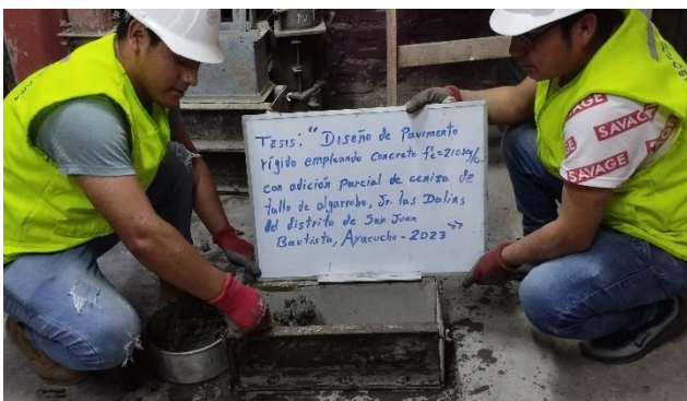
Fotografía 23: Elaboración de viguetas de concreto.
