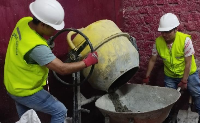
Fotografía 19: Elaboración del diseño de mezcla del concreto.
